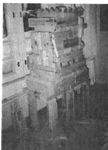
Linnan torni kohoaa steiner- päiväkodin eteisessä ja kau- punki laajenee sen juurella.
