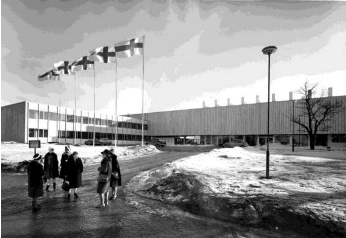
Tampereen yliopiston päärakennus (Tampereen yliopiston arkisto)
