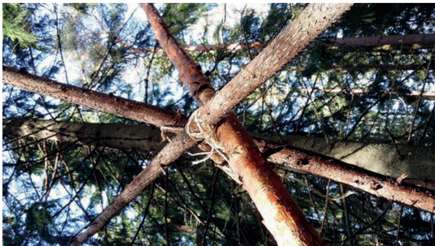
Ensimmäisen kodan tukirakenteet pystytettynä.
