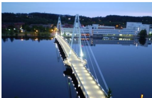
Ylistön silta, Jyväskylä
