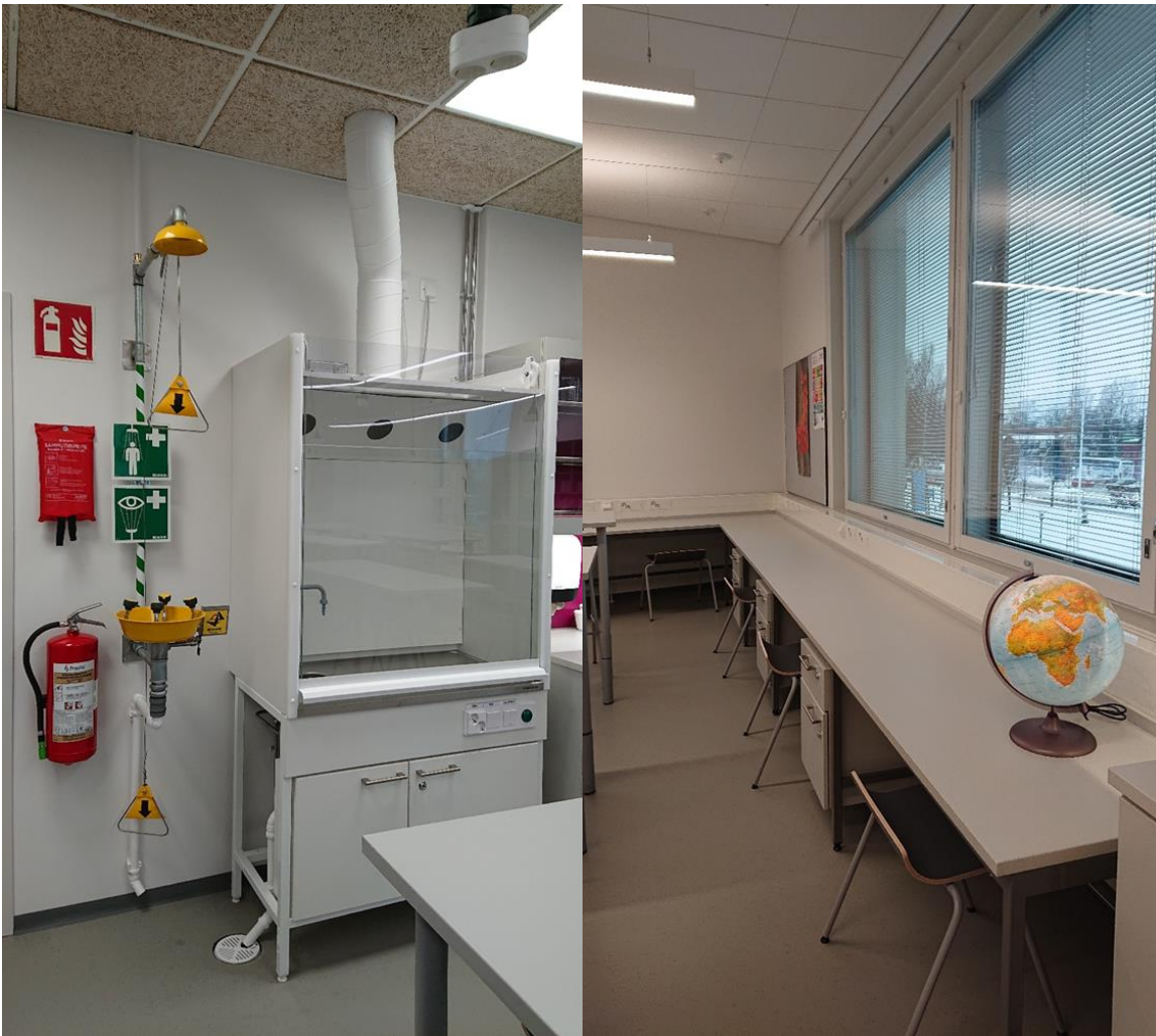
Luokassa on kiinteä vetokaappi, silmä- ja hätäsuihku, jauhesammutin ja sammutuspeite. Kahdella seinällä on matalampaa sivupöytää ja jakkaroita. Sivupöydälle on tarkoitus sijoittaa lämpökaappi, joka hankitaan myöhemmin. Teksti ja kuvat: Hanna Suopajarvi.
