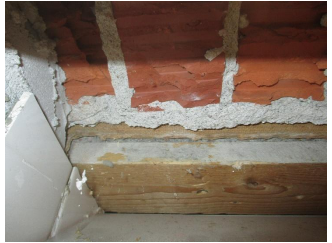
Kuva 8: Vanhan ja uuden osan liittoksessa vanhatiilimuuraus, rappaus, kovalevy ja betoni
