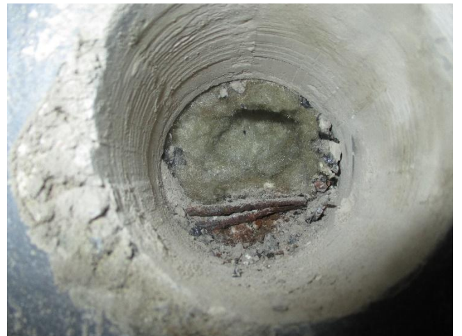
Kuva 10: Sokkelihalkaisueristeenä mineraalivilla
