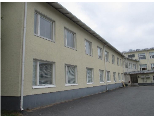
Kuva 3: Yleiskuva, uusi osa, julkisivu etelään
