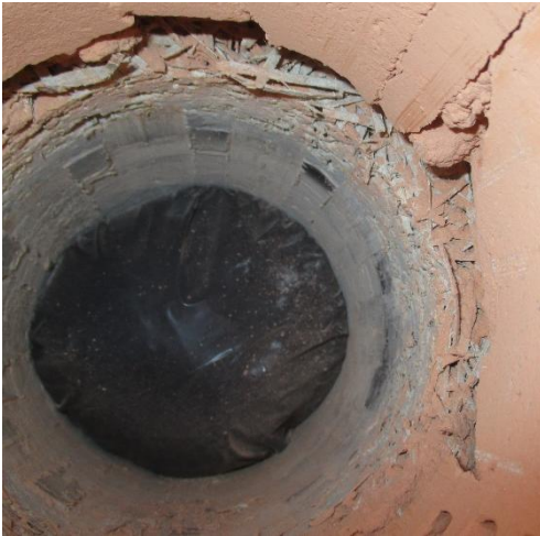
Kuva 7: Tiilen takana Toja-levyä ja betonipalkisto
