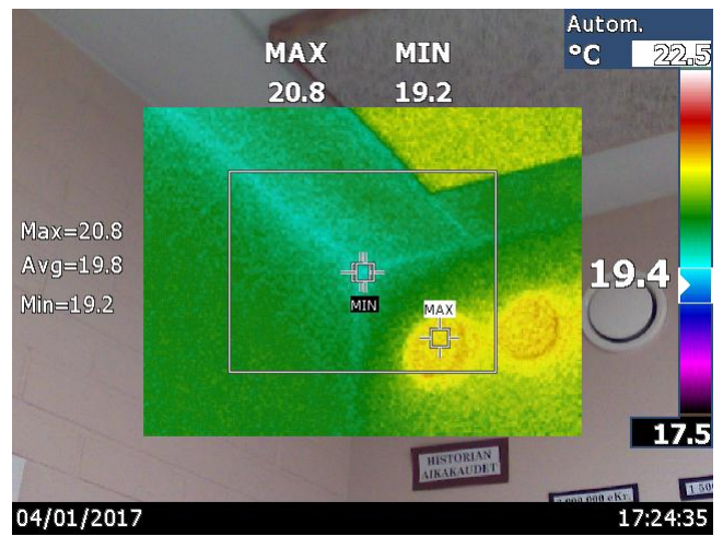
Kuva 16: Luokka 242, väliseinien nurkka, alipaine
