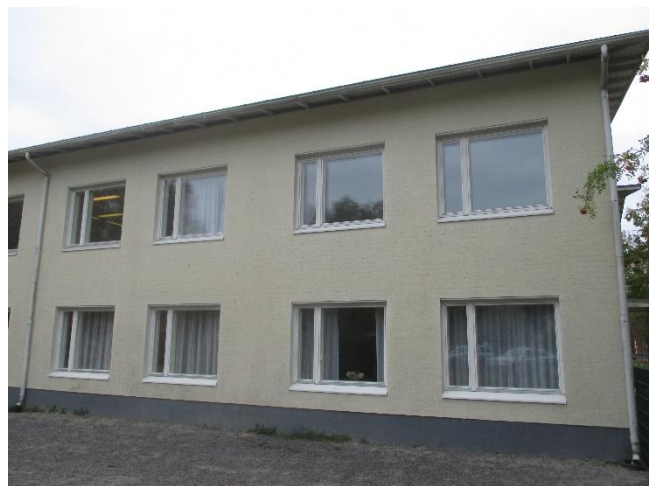
Kuva 4: Yleiskuva, uusi osa, julkisivu pohjoiseen
