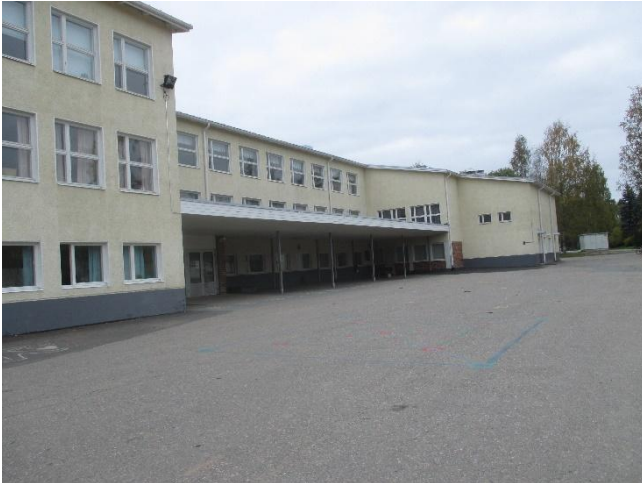
Kuva 1: Yleiskuva, vanha osa, julkisivu itään
