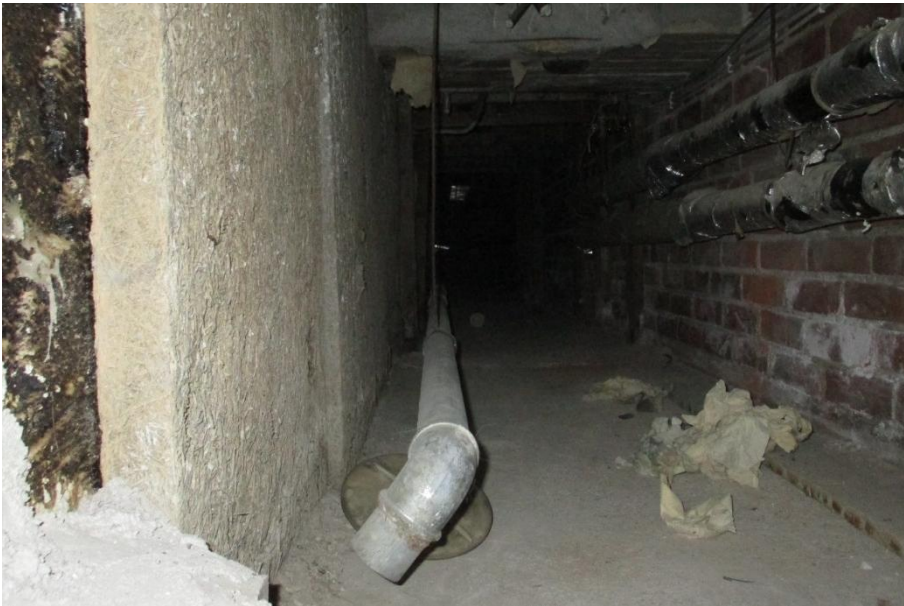
Kuva 2. Lattian aluskanaalin musta siveley sisältää PAH-yhdisteitä yli Ratu-kortti 82-0381 määritellyn vaarallisen jätteen rajan 200 mg/kg.
