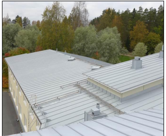
Kuva 38. Vesikatteet ovat saumattuja teräspelti-katteita.
