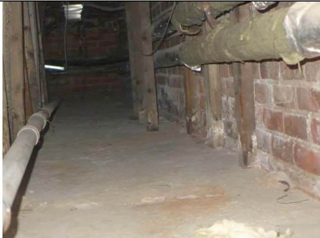
Kuva 11. Vanhan osan 1.kerroksen lattia-seinäliittymissä on tarkastetuain osin rakoilua, jota myötä tiloihin pääsee korvausilmaa alapohjarakenteista ja maapohjasta .
