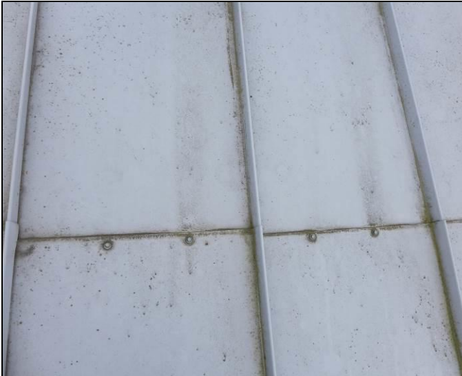
Kuva 39. Vanhan osan puolella teräs-peltilevyjä on kiinnitetty ruoteisiin kansiruuveilla.
