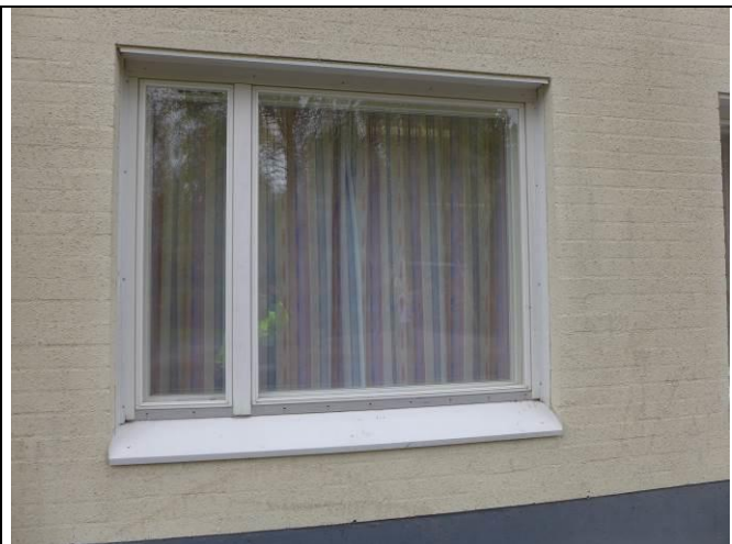
Kuva 33. Yleiskuvaa laajennusosan ikkunasta.
