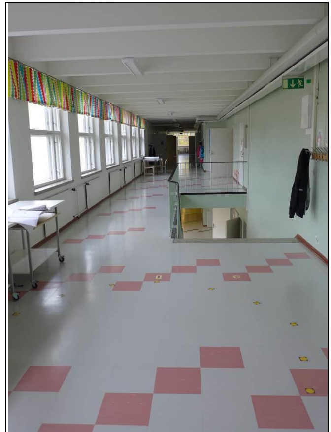
Kuva 46. Yleiskuvaa vanhan puolen 3. kerroksen käytävältä.
