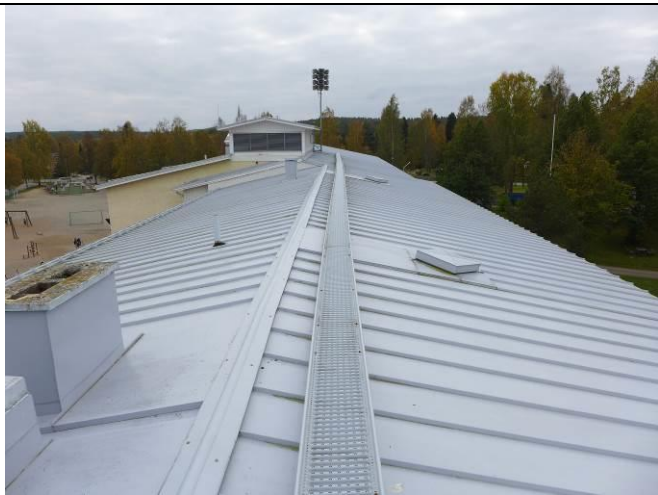
Kuva 37. Vesikatteet ovat saumattuja teräspelti-katteita.
