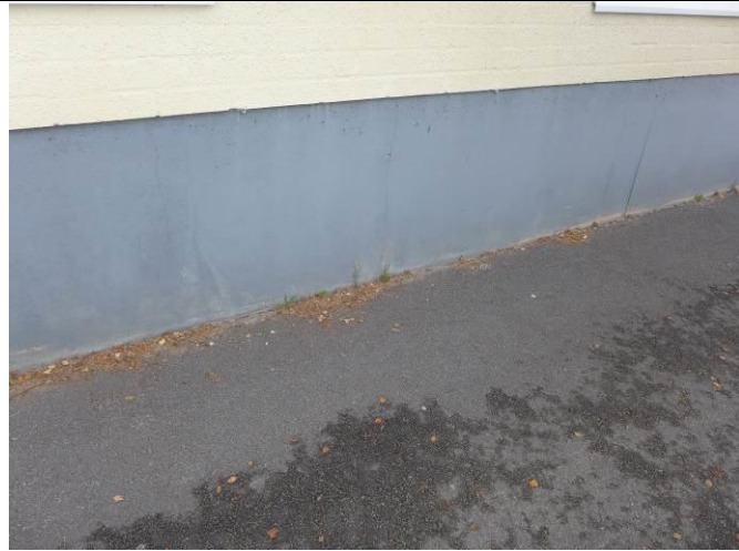
Kuva 7. Laajennusosan sokkelipinnoilla esiintyy maalauspinnan osittaista kuluneisuutta.
