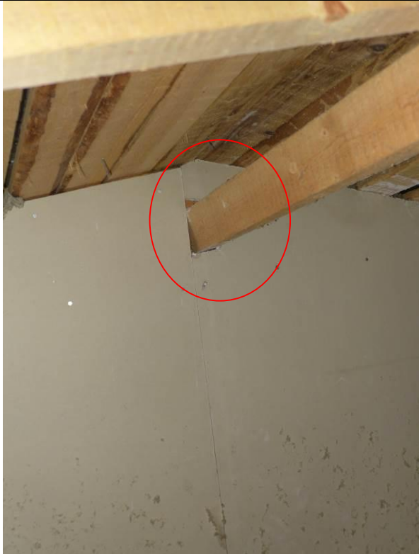
Kuva 23. Palo-osastastointien väliset levyseinät eivät ole kokonaisuudessaan tiiviitä laajenusosan yläpohjatilassa.
