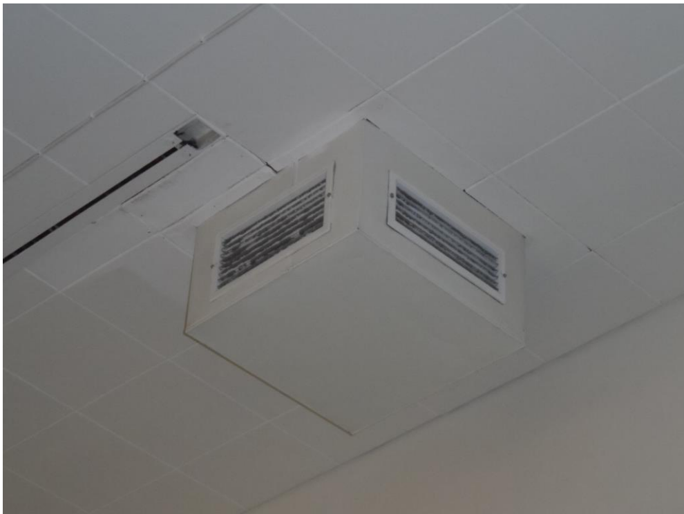
Liikuntasalin katossa olevien poistopiippujen kautta tulee sulamisvedet salin lattialle.
