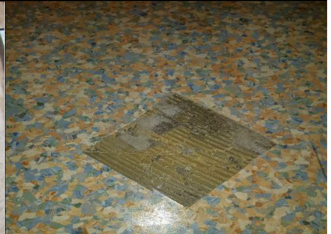
Kuva 18. Kuvaamataitoluokan muovimatossa (uusitulla lattian alueella) kemiallista hajua muovimaton alla. VOC 2 näytteessä ei kuitenkaan VOC-yhdisteiden viitearvot ylity.
