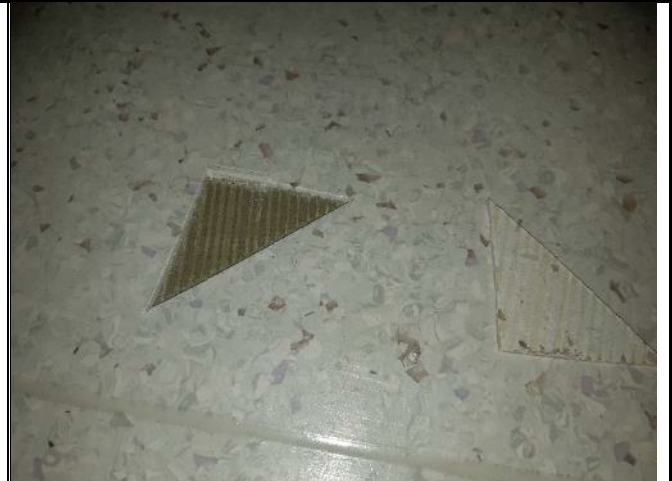
Kuva 63. 2.krs luokkatiloissa muovimaton alla ei havaittu voimakkaita hajuja.
