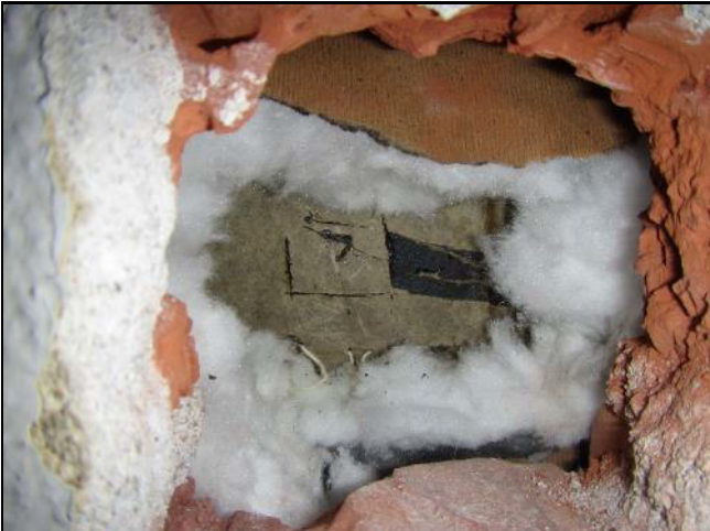
Kuva 23. US1. Eristeenä valkoinen villamatto, jossa molemmin puolin tervapaperia. Ulkokuoren puolella myös pikisively. Rakenneavauksesta tuli hieman PAH-yhdistemäinen haju.
