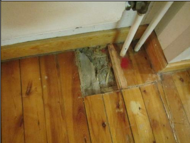
Kuva 57. Toinen rakenneavaus liikuntasaliin. Käytetty eri viljaa kuin edellisessä. Patteriputkien kohdalla betoninen valu. Puun haju rakenneavauksesta.
