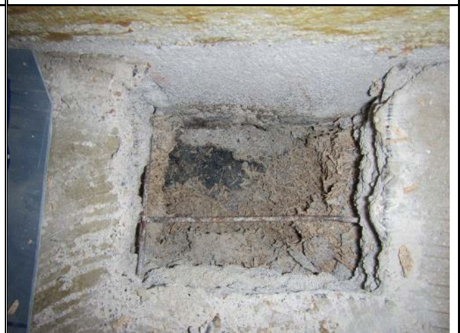
Kuva 10. 1.krs alkuperäinen alapohjarakenne kuten AP1.Tojaeristeen alla pikieriste näkyvissä.
