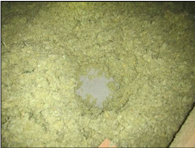
Kuva 44. Yläpohjassa puhallettu villa palopermannon päällä.
