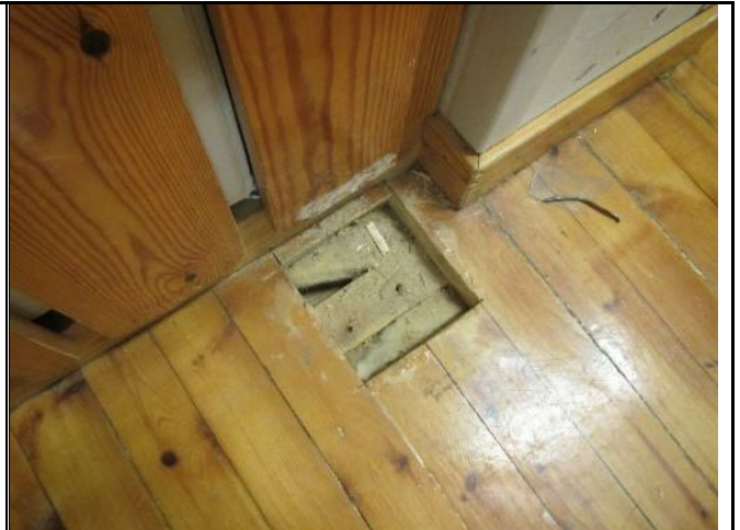
Kuva 56. Liikuntasalin rakenneavaus ja näytteen M3 kohta. Ei erikoisempaa hajua havaittu rakenneavauksesta, puun haju. Rakenne VP2.
