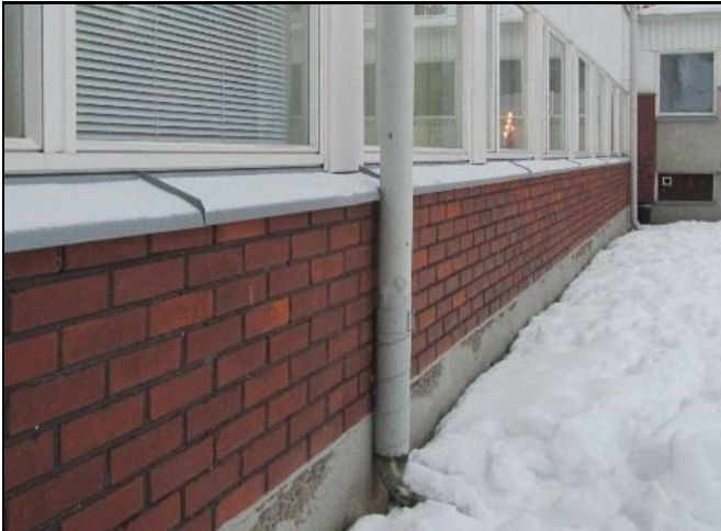
Kuva 1. Syöksytorvia on korjattu kierresaumatulla peltiputkella (vrt. IV-kanava).
