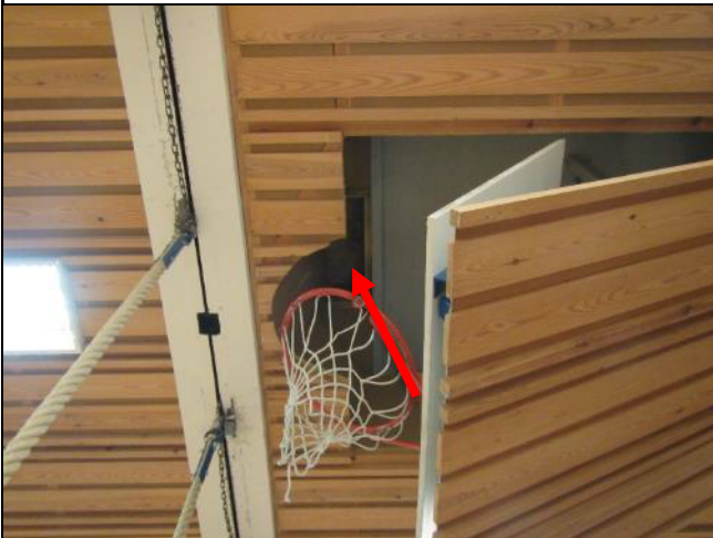
Kuva 54. Liikuntasalin koripallorenkaalle tehty syvennys yläpohjarakenteeseen. Betoninen sisäholvi poistettu ja tojaeriste näkyvillä sisälle.
