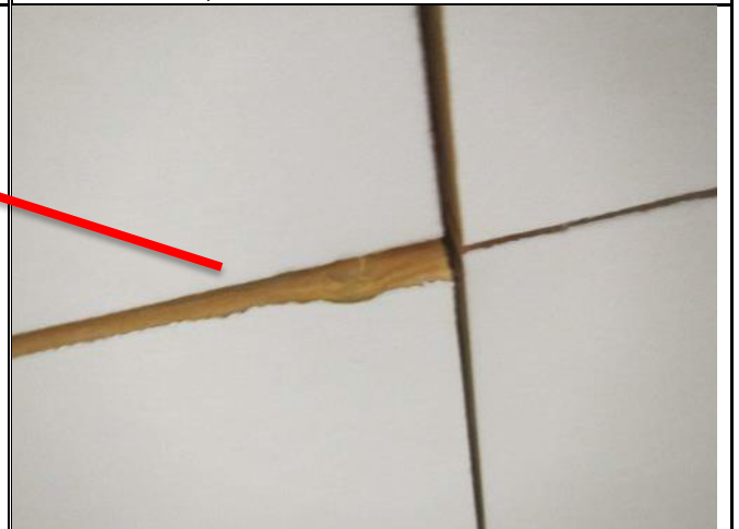
Kuva 61. Villakuidut voivat irrota akustolevyistä ja heikentää sisäilmanlaatua.
