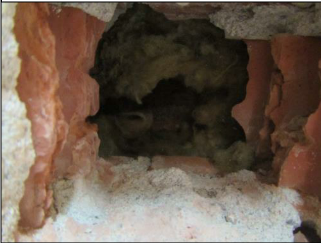
Kuva 25. US3. Villaeristeen takana paksuhko pikisively.
