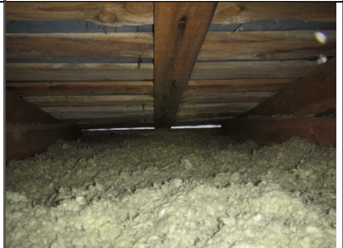
Kuva 49. Yläpohjassa itäpuolen tuuletusraot räystäälle ka-peita, länsipuolelle tuuletus uusittu verkkoineen
