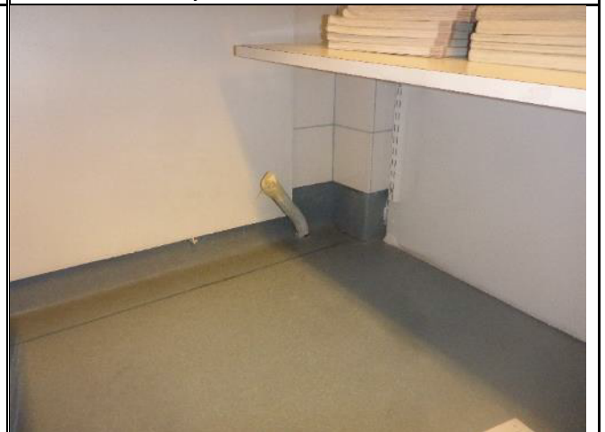
Kuva 14. Musiikkiluokan varastossa käytöstä poistettu muoviputki. Ei havaittu hajuja eikä vuotoja merkkiainekoiden yhteydessä. Putkesta ei tarkempaa tietoa.
