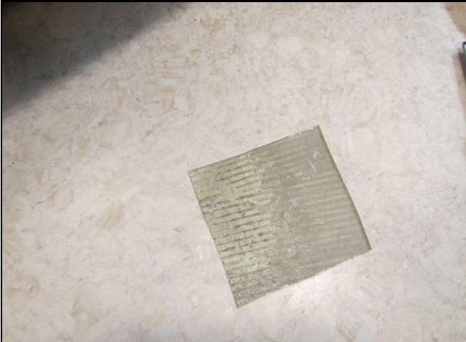
Kuva 17. VOC1 näyte. Opettajanhuoneen muovimaton alta voimakas kemiallinen hajua ja analyysissä VOC-yhdisteet ylittävät viitearvot. Liimassa on värieroja kohdalla.
