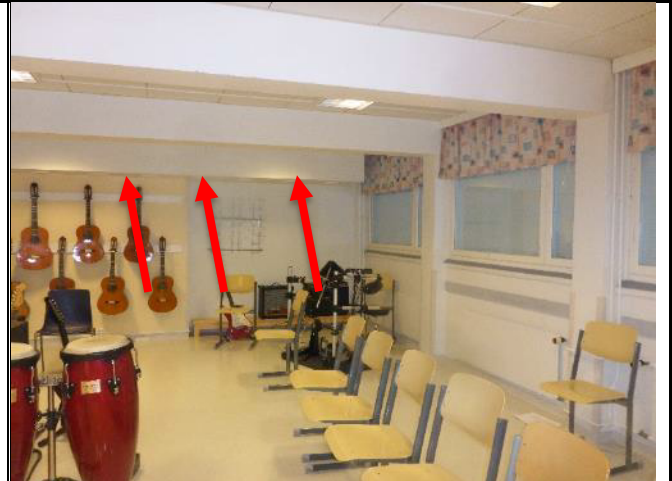
Kuva 69. Musiikkiluokassa tuloilmaventtiilit vain toisella puolen tilaa. Tuloilma huuhtelee vain osan luokasta.
