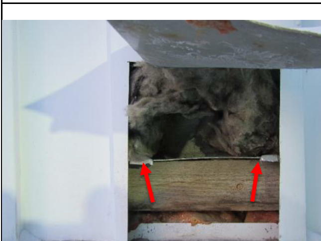
Kuva 38. Pellityksen "rimat" toimivat kiinnikkeinä ja tukkii ilmaraon.
