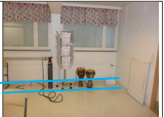
Kuva 22. Musiikkiluokan puolella tehtiin merkkiainekokeita syöttämällä kanaaliin kaasua. Kanaalista sisäilmaan ei havaittu vuotoa. Kanaalin kohta on merkattu sinisin viivoin.
