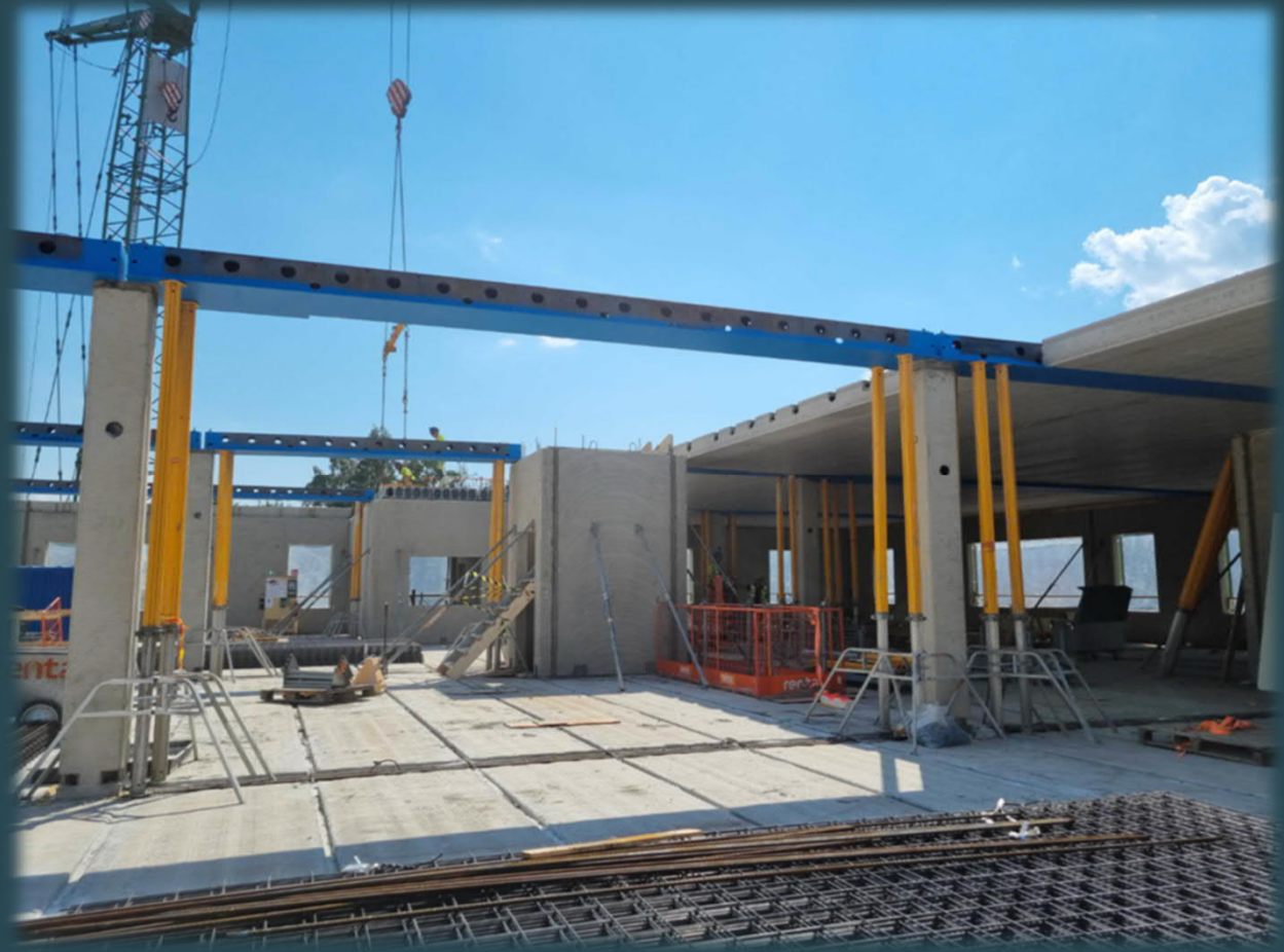
Ontelolaattojen asennus 3. kerros
