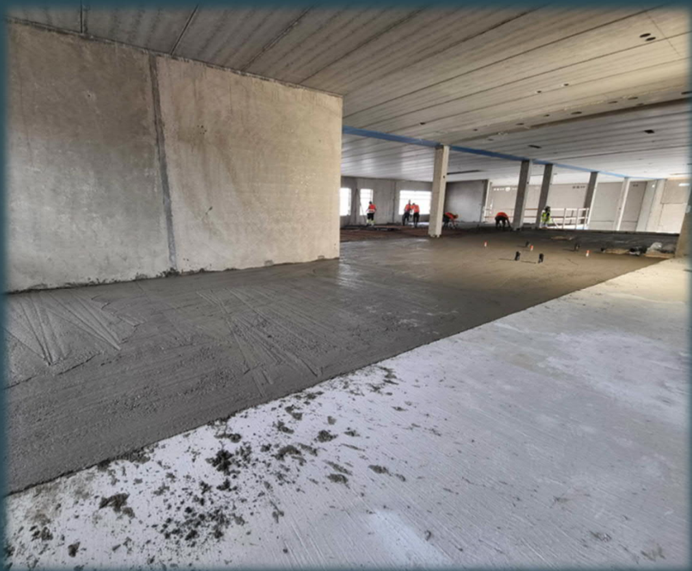
Pintabetonilattian valu 2. kerros
