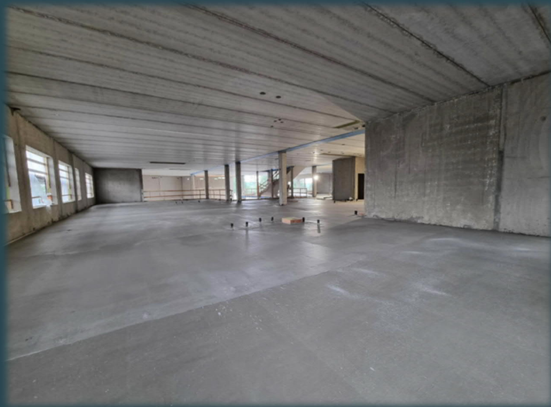
Valmis pintabetonilattia 2. kerros
