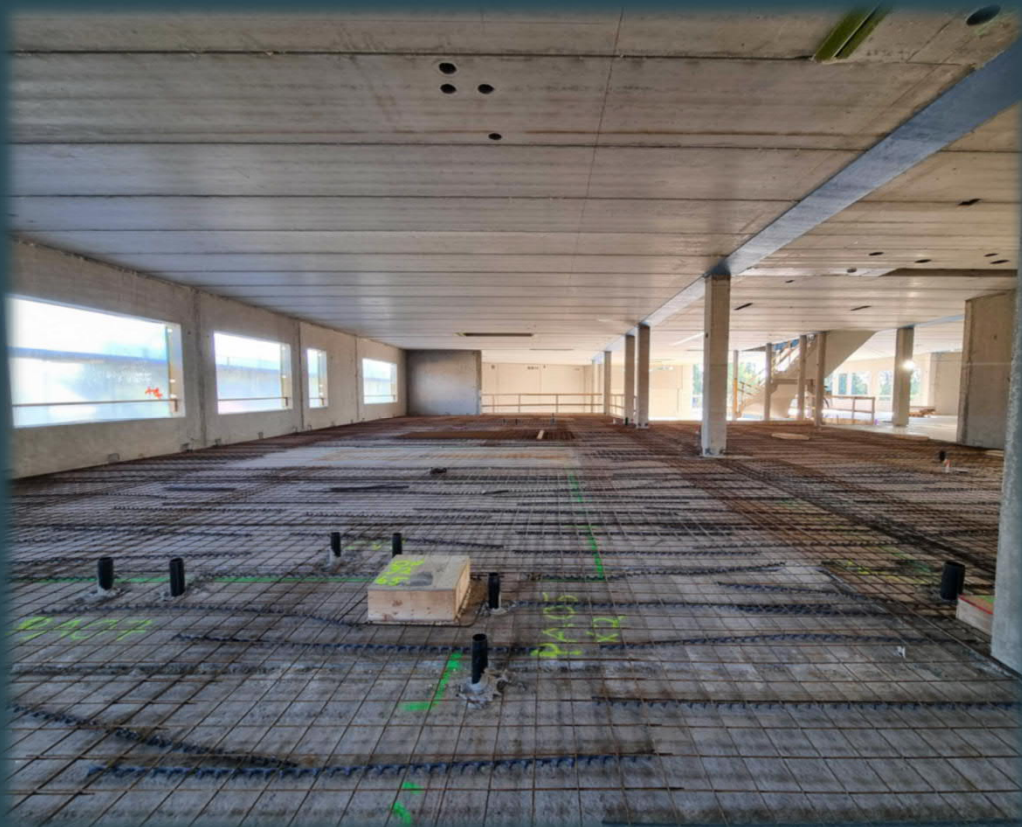
Pintabetonilattian raudoitus 2. kerros
