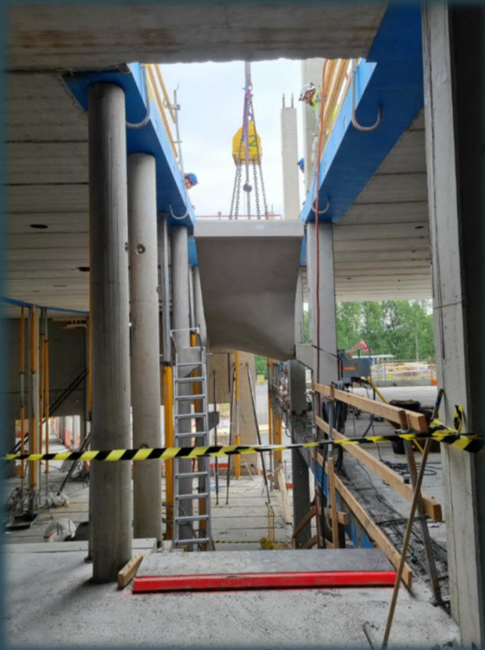
Portaiden asennus 2. kerros
