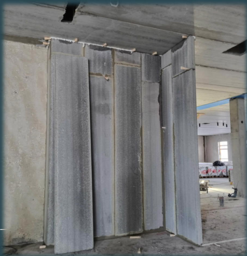
AKO-VÄLISEINÄELEMENTTIEN ASENNUS 1. KERROS
