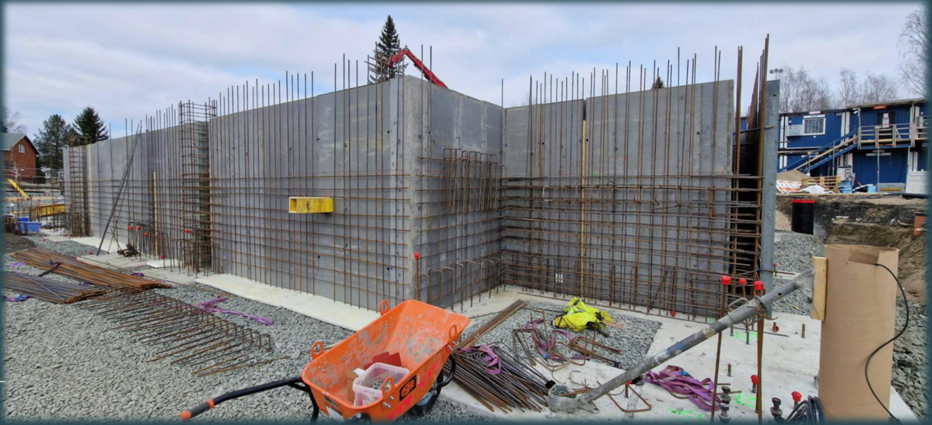
Väestönsuojan sokkelin muotit ja raudoitus
