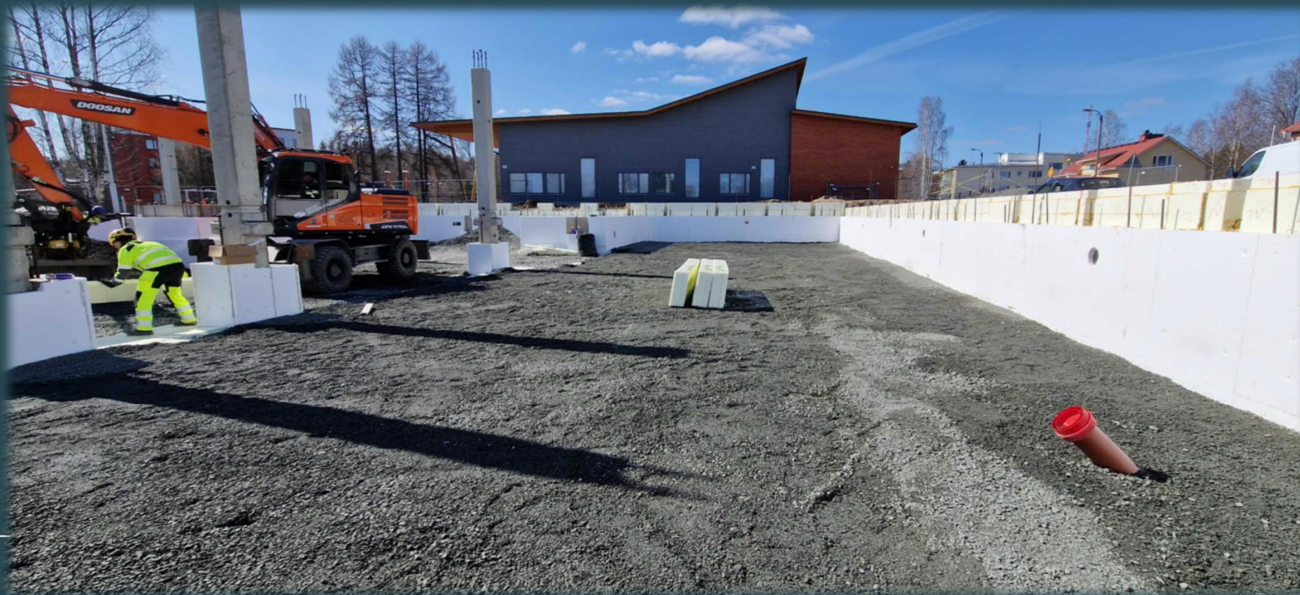
Alapohjan eristys ja murske
