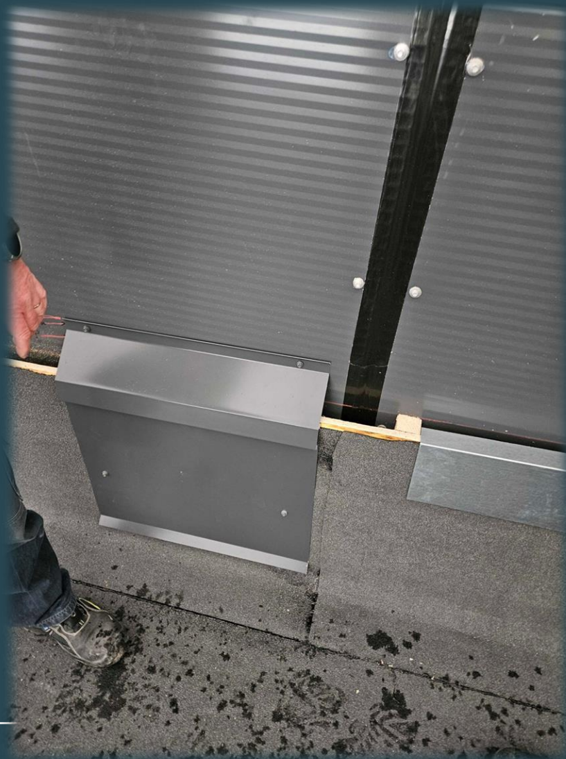
Vesikaton ylösnostojen mallipeltiprofiili tarkastus
