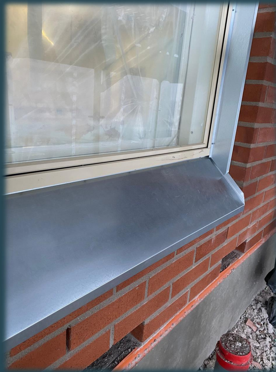
Ikkuna mallipeltiprofiili tarkastus
