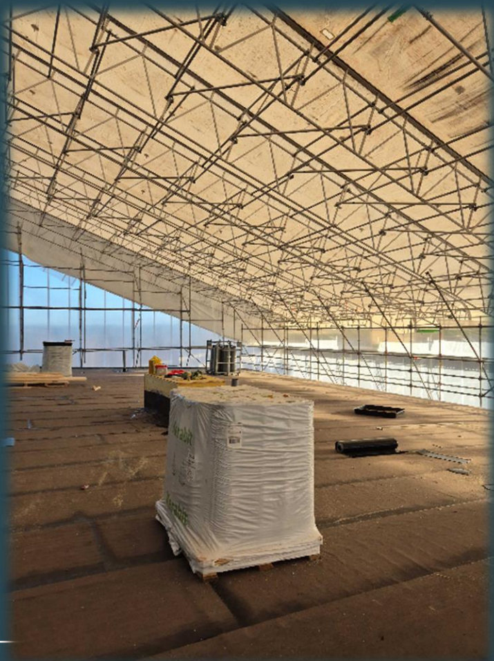
Vesikaton pohjakermiasennus B-lohkolla
