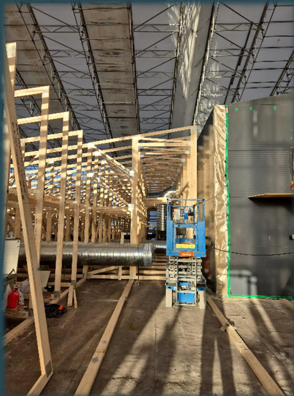
Vesikaton ristikkoasennus C-lohkolla
