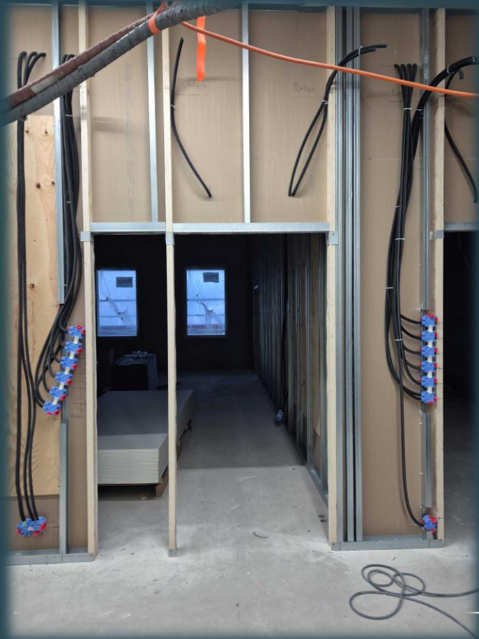
Väliseinien sähköputkitus ja - rasiointi
