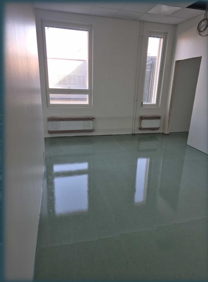
3C lattian pinnoitus käynnissä
