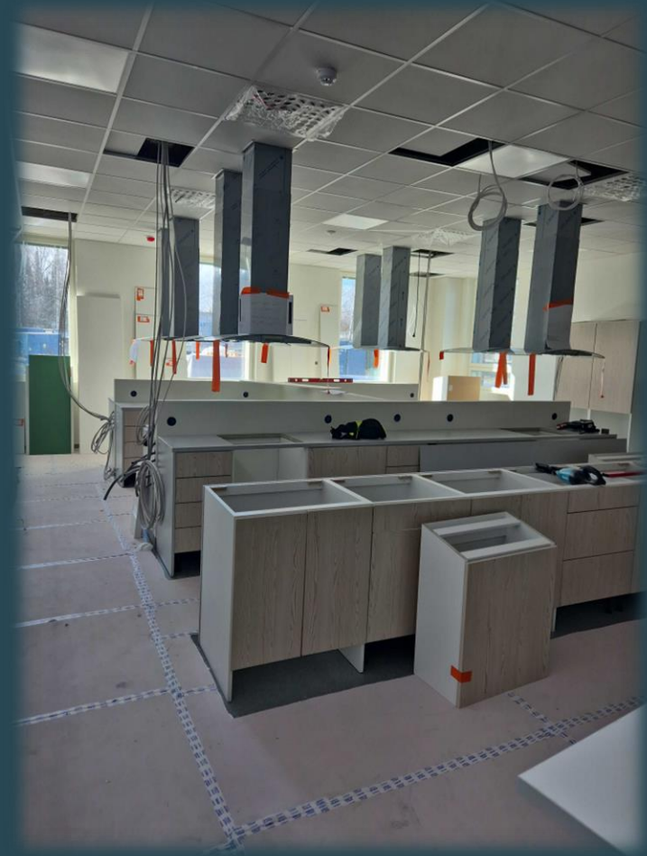
Kotitalousluokan kalusteasennus käynnissä
