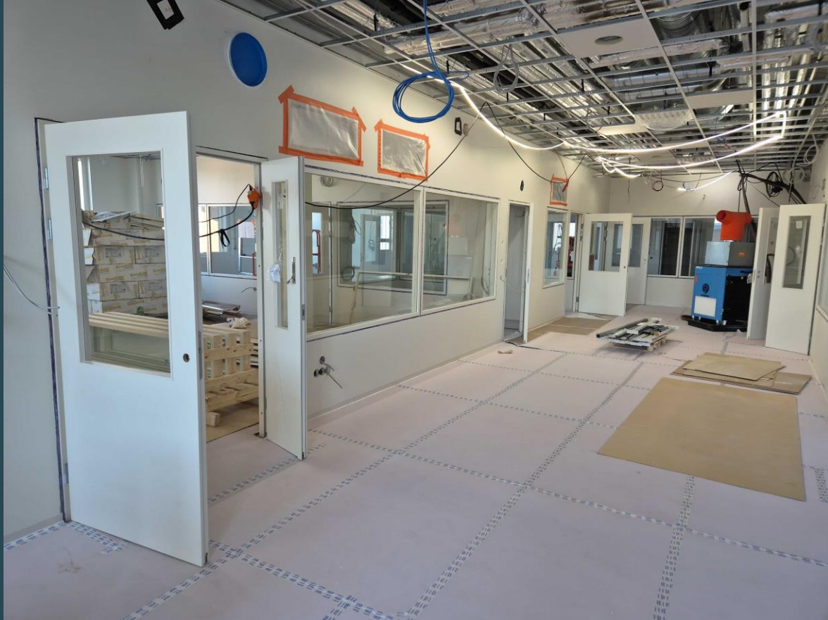
Sisä ovi- ja ikkuna asennusta
