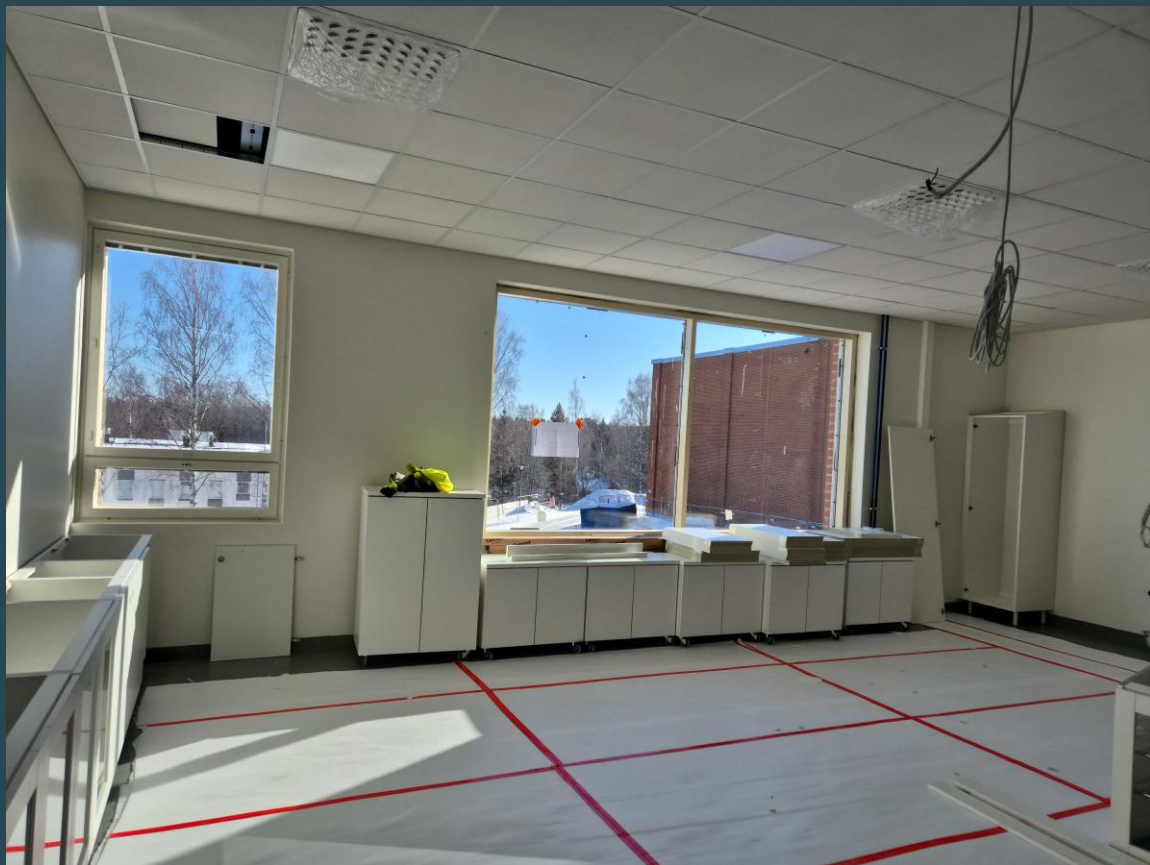
Kalusteasennus A-lohko 2.krs
