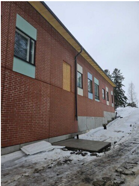
Syöksyt ja rännit asennettu
