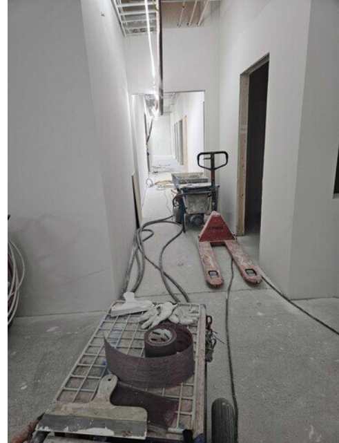
Viimeisiä tasoituksia 1. kerroksessa
