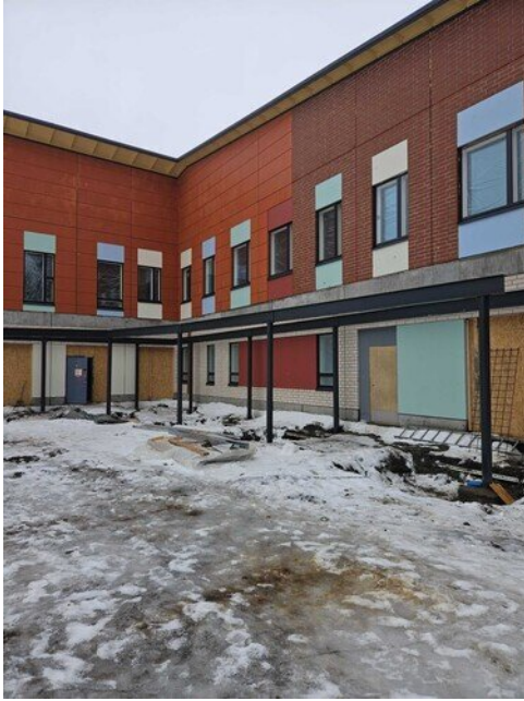
Pääsisäänkäynnin katoksen runko pystytetty
