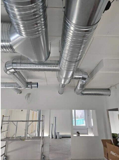
IV-kanavoinnit aloitettu pölypuhtaassa tilassa
