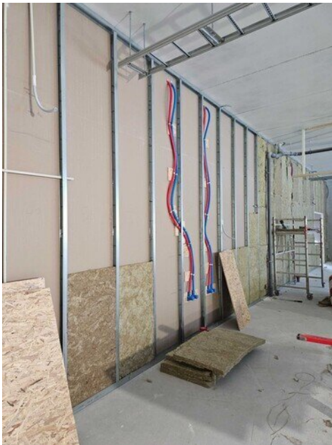
Viimeisiä levytyksiä 2. kerroksessa
