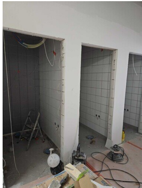
Laatoitusta aulan wc-tiloissa
