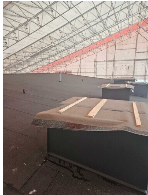
ÍV-konehuoneen ulospuhallushajottajat vielä puuttuvat
