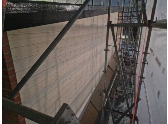
Vanhan ja uuden osan liitoksen paneloitua ulkoseinää
