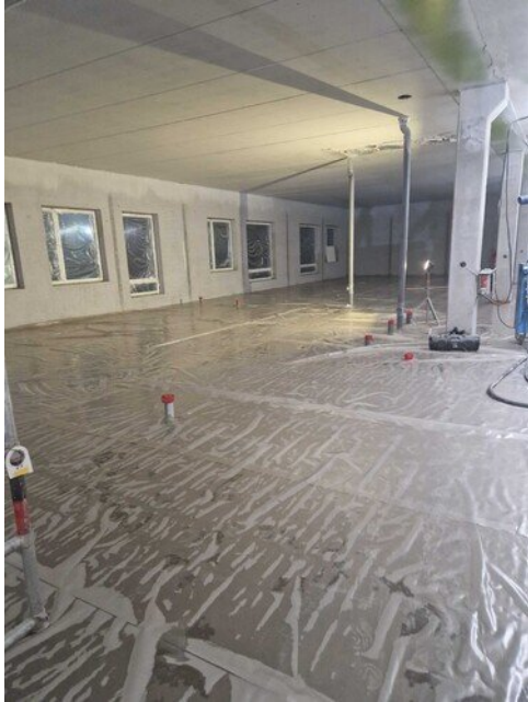
Ensimmäinen osa valettu 2 krs pintalaatasta, jälkihoito menossa.
