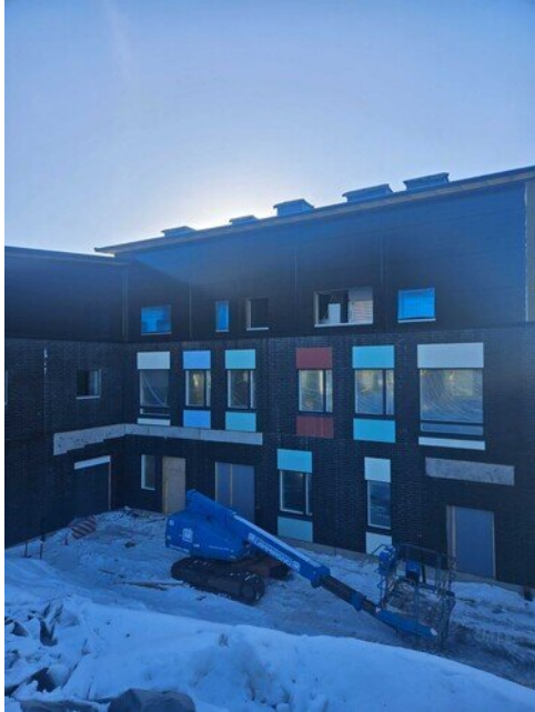
Raitisilma aukot tehty ja kammioiden asennus kesken
