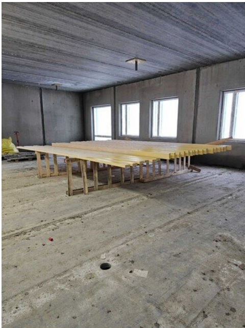
Maalausosasto ollut töissä
