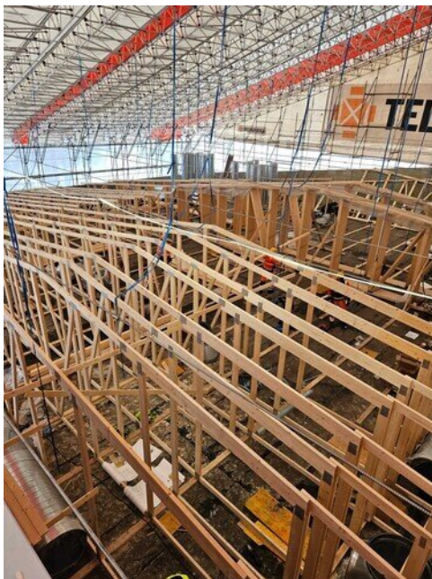
Kattoristikoita vielä asentamatta
