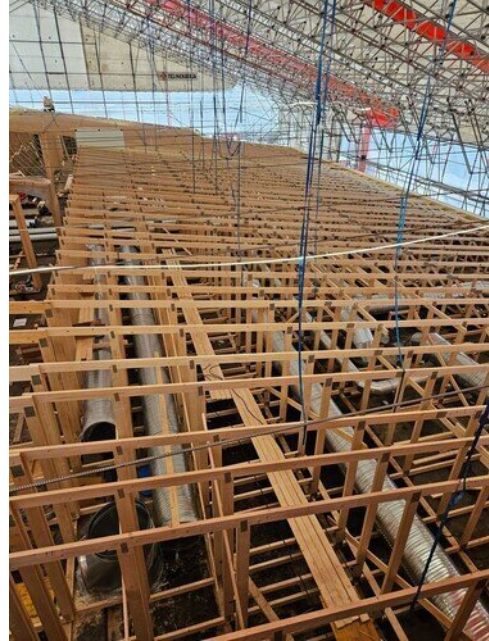
Kattoristikot asennettu
