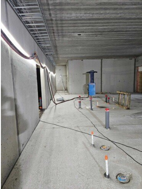
Lämmitin 1 krs pukuhuonetilat ja sähköhylyjä asennettu
