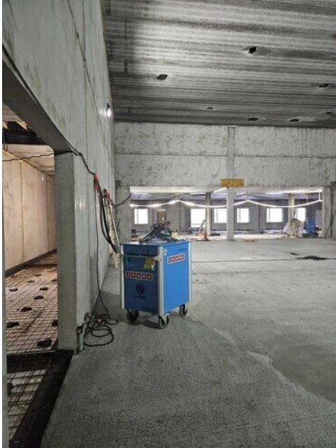
Väliaikaiset vesikiertoiset lämmittimet paikoillaan, 8 kpl.
