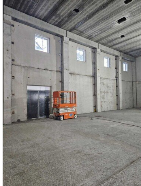
Liikuntasalissa savunpoistoikkunat paikoillaan
