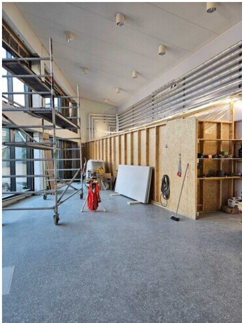
Vanha aula, uusi väliaikainen kulkutunneli
