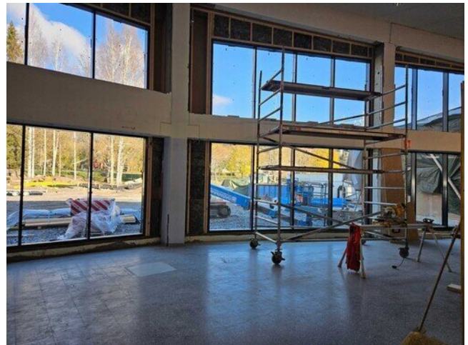
Uudet ikkunat asennettu vanhaan sisäänkäyntiin
