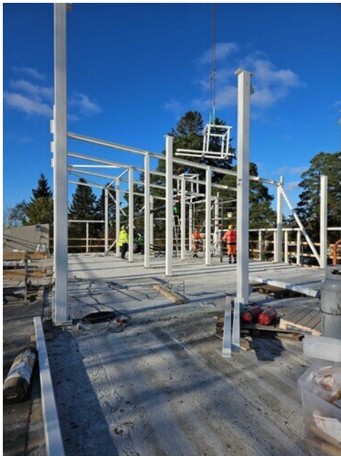
IV-konehuoneen runkoa pystytetään
