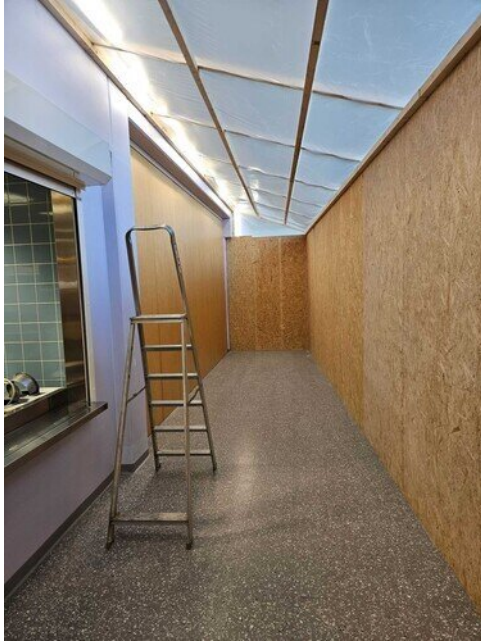
Väliaikainen kulkutunneli aulassa
