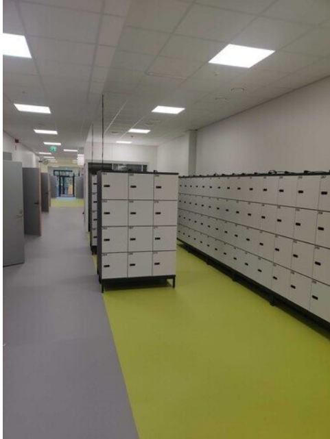
2 kerroksesta lattiasuojia poistettu ja siivouksia käynnissä
