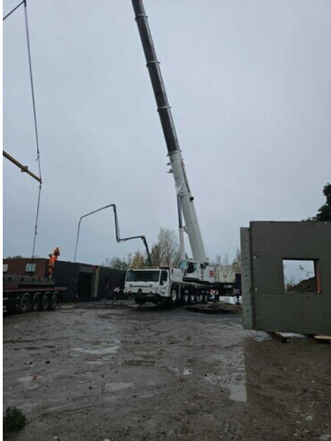
Elementtinoistoja ja holvinjuotosta yhtä aikaa
