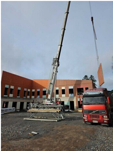
Tämän työmaan viimeinen seinäelementtinoisto
