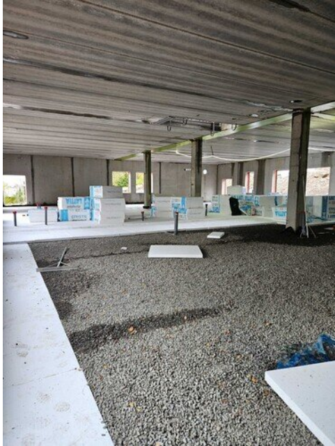
Lattiaeristeasennukset aloitettu teknisentyön siivestä
