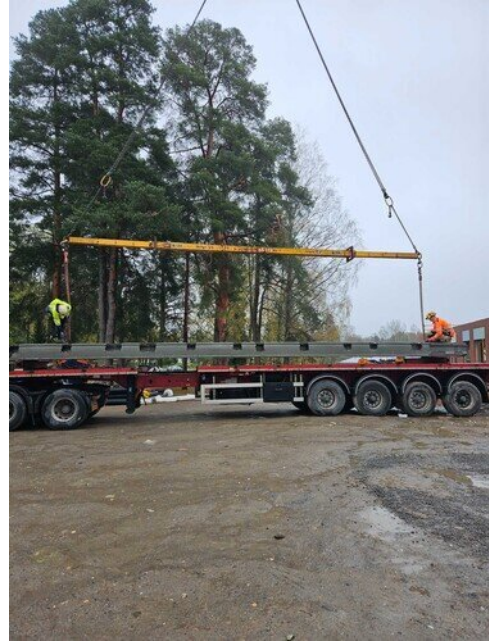
Tämän työmaan viimeinen ontelonosto
