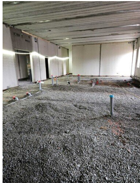
Viemärihajotukset pukutiloissa valmiit
