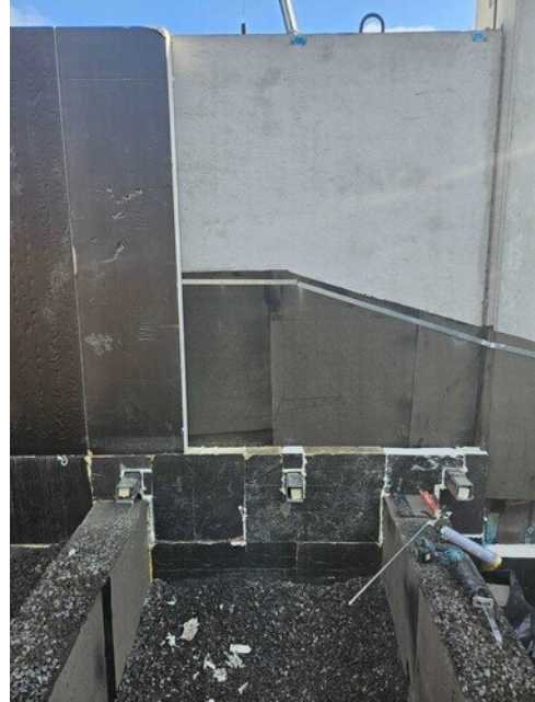
Liikuntasalin maanpaineseinää, vesi ja lämpöeristys
