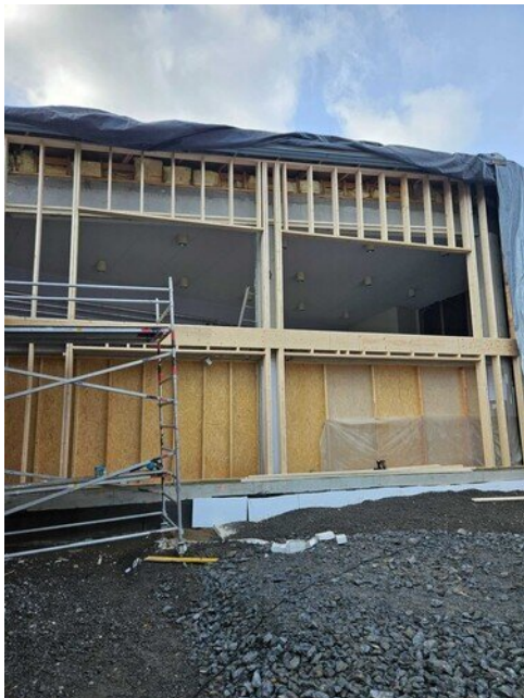
Vanhan ulkoseinän uutta puurunkoa
