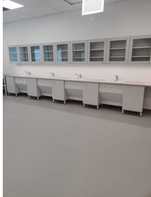
Isvet kalusteiden asennusta
