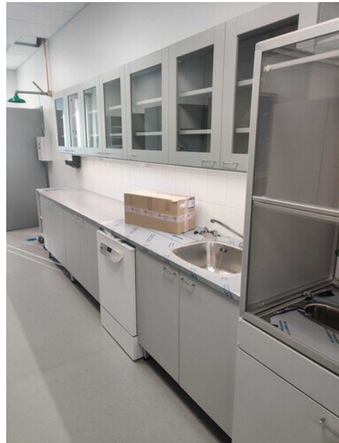
Kemian ja fysiikan luokan varaston kaluste asennuksia
