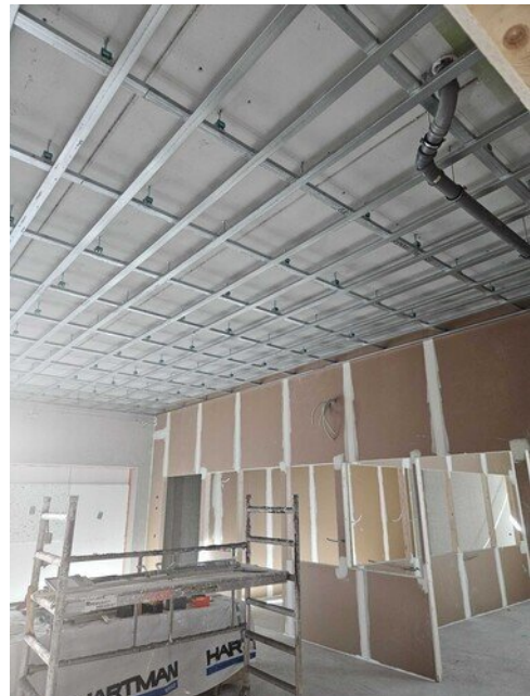
Akustiikkakattorunkoa metallityöluokassa
