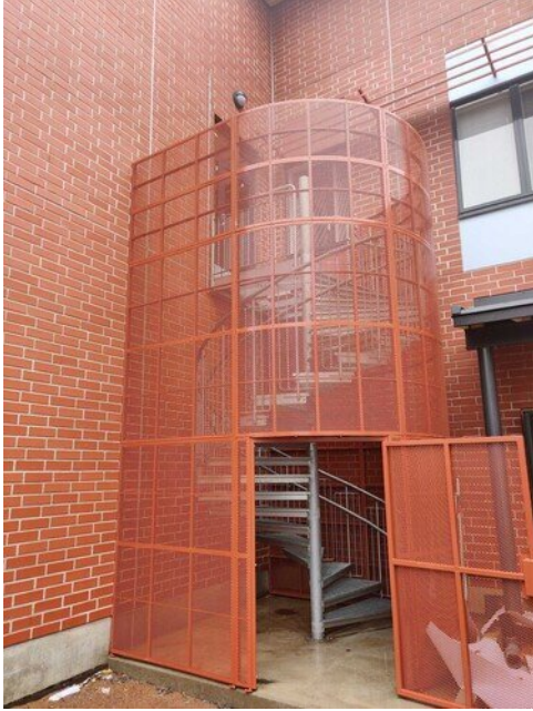
Kierreportaiden ulkokehikon asennus
