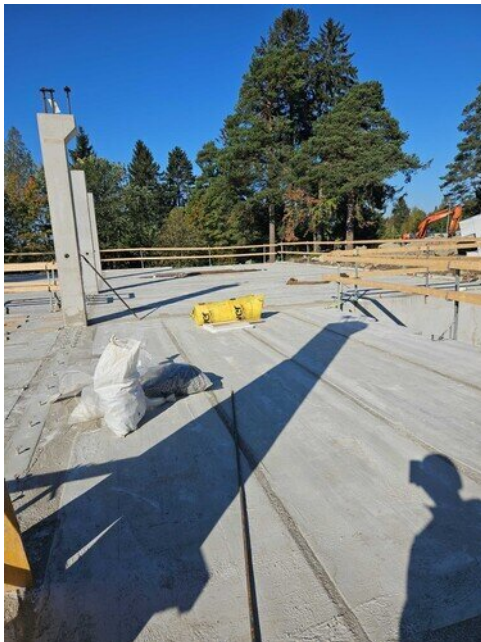
Tarvikkeet odottaa elementti asennusta
