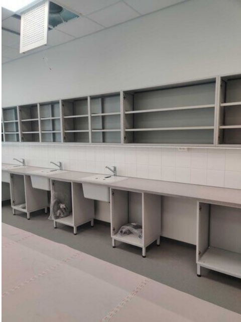
Viimeisiä kaluste asennuksia
