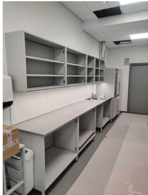
Viimeisiä kaluste asennuksia
