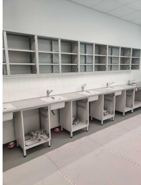
Viimeisiä kaluste asennuksia
