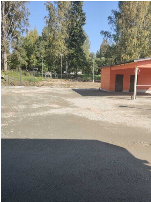
Pihojen asfalttipohjia tehty
