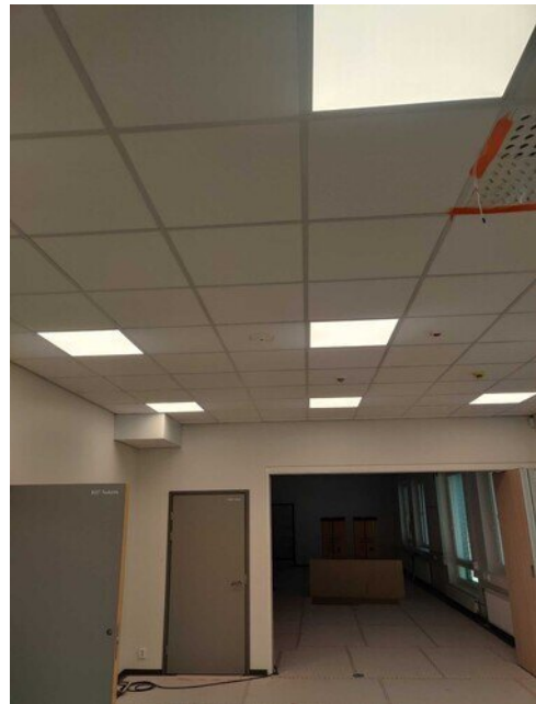
Opettajien taukotilan alakatto asennettu
