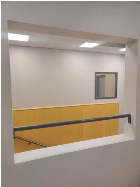
Rappusiin ja aukkoon asennettu kaiteet
