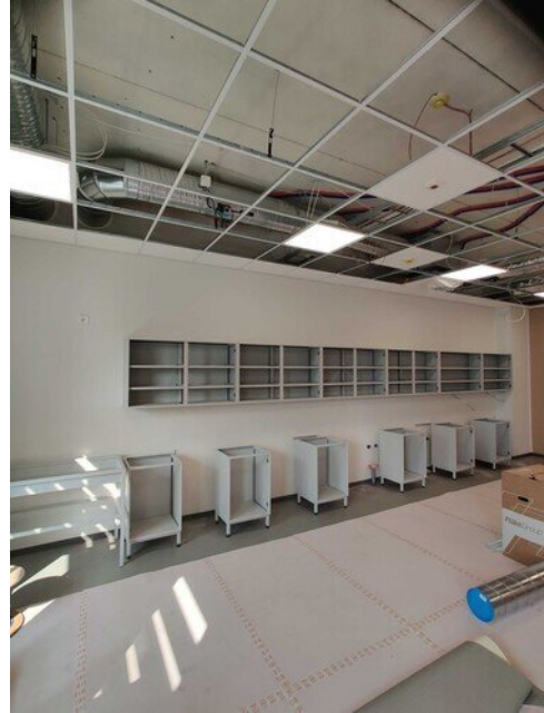
Biologia/maantieto luokan kaluste asennuksia
