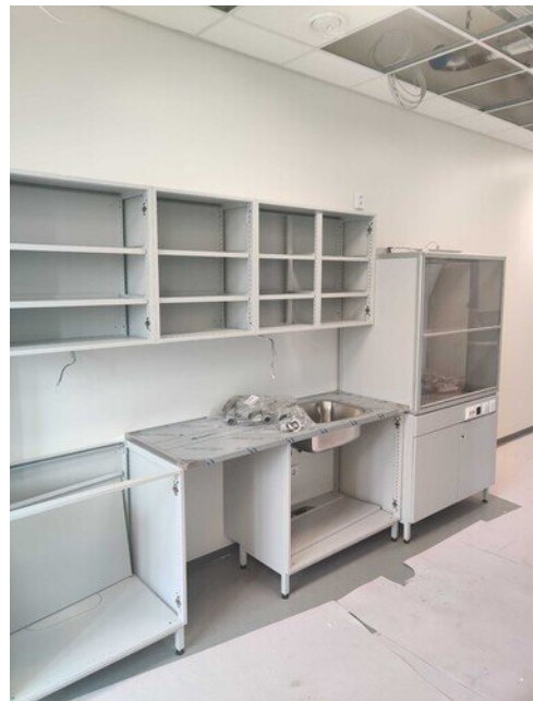
Isvet kalusteita saapui työmaalle
