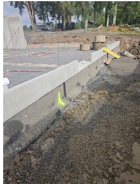
Sokkelin ulkopuolen vesieristykset tehty
