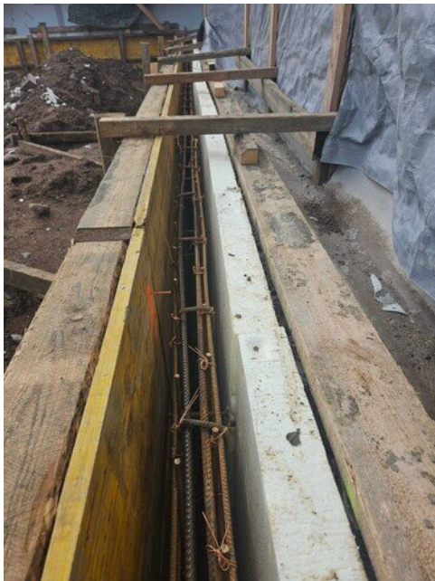
Vanhan rakennuksen reunaan sokkelivalu
