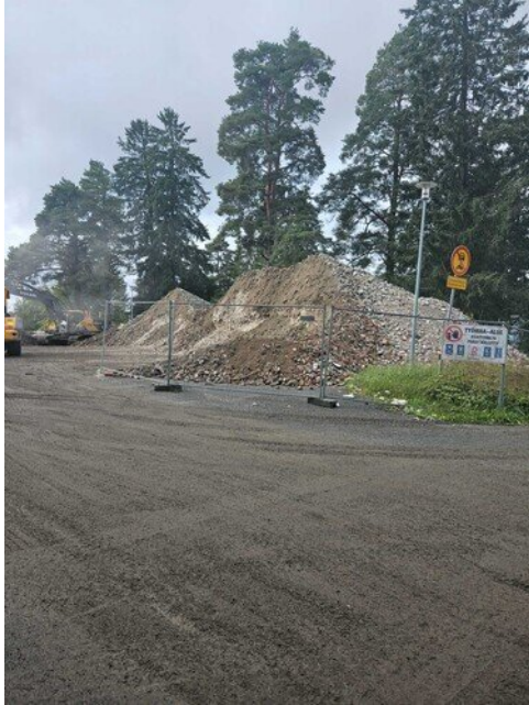
Vielä on betonimurskekaa vähän jäljellä
