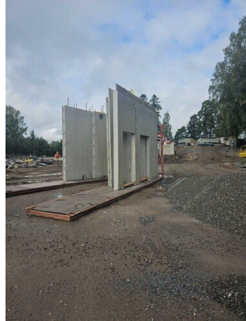
Väliseinäelementtejä jo tuotu, maanantaina asennus
