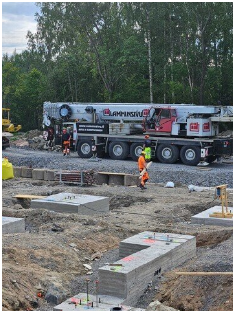
Nosturi saapui työmaalle
