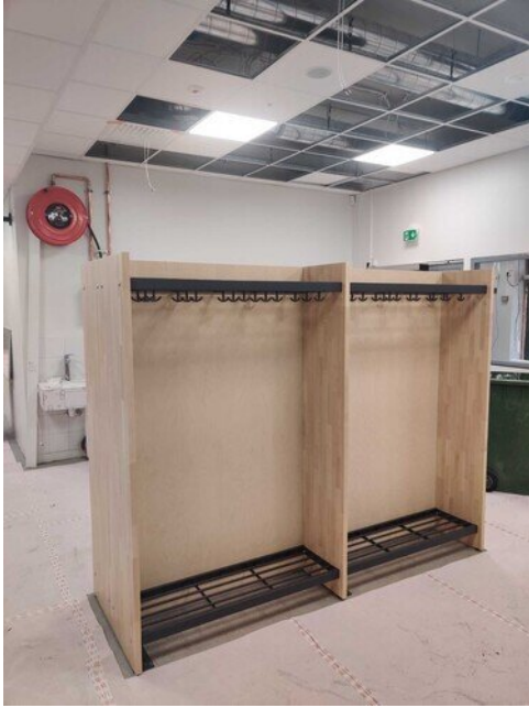
Pääsisäänkäynnin edessä naulakoita
