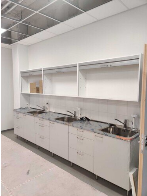
Kuvataide luokan kalusteasennusta
