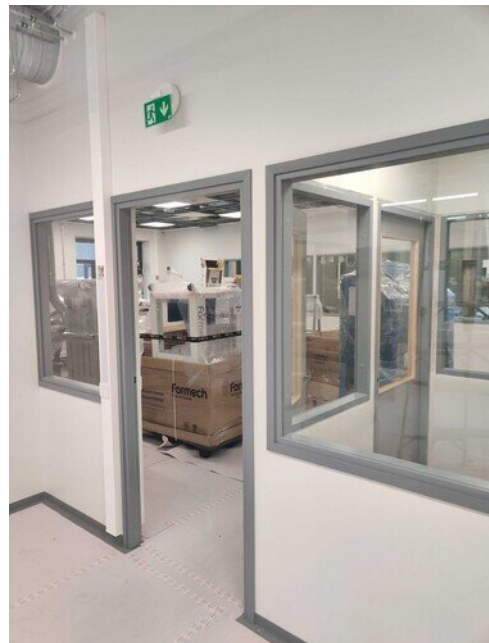
Teknisen työn ovi ja ikkunalistoitusta
