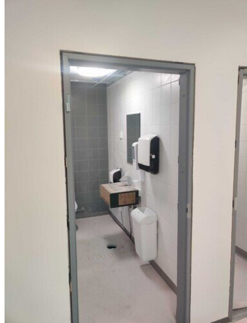
2 kerroksen karmien asennusta
