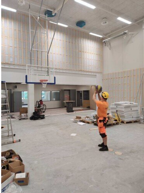
Työmaalle lavastettiin koripallon pelaaja
