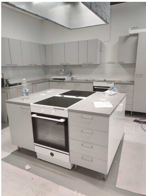
Kotitalousluokan liesiä asennettu
