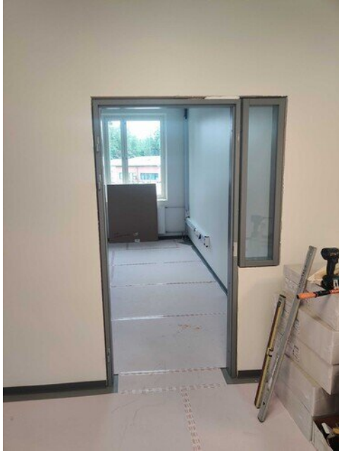
2 kerroksen ikkuna asennus
