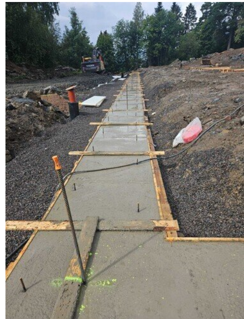
Takaseinän anturaa, jälkihoito tuli sopivasti taivaalta
