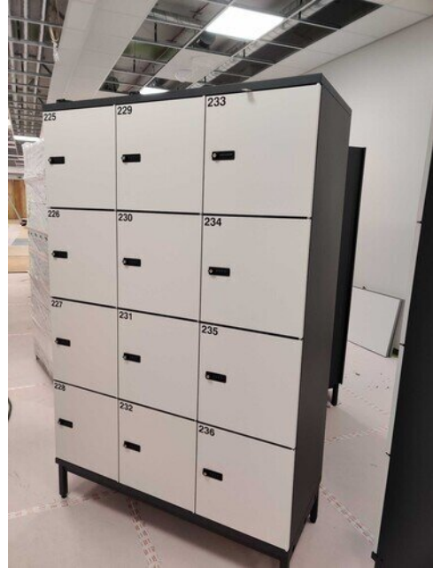
Lokerikot saapui työmaalle
