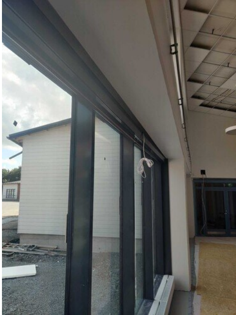
Vanhan aulan pimennysverhot asennettu
