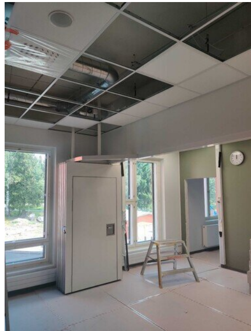
Erityisopetuksen tiloihin siirtoseinän asennus
