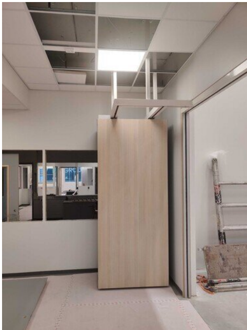
Liikuntasalin siirtoseinän asennus
