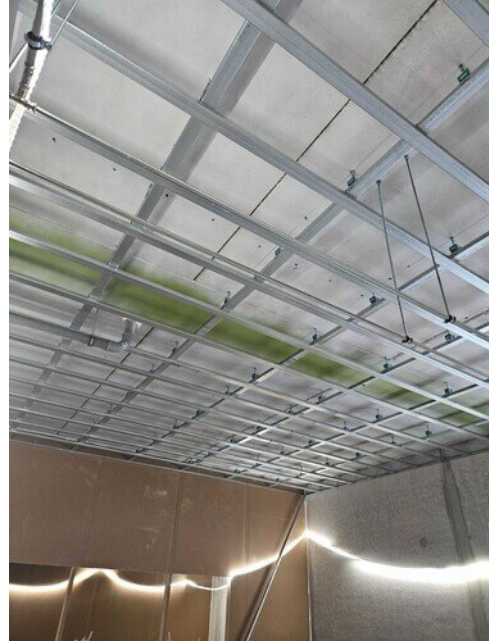
Ääntäeristävä alakattorunko teknisessä työssä
