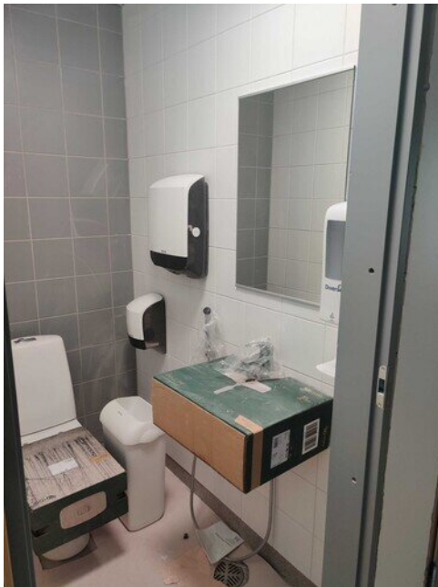
Wc varusteiden asennusta
