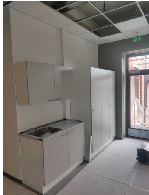
Matematiikan luokan kalusteasennuksia
