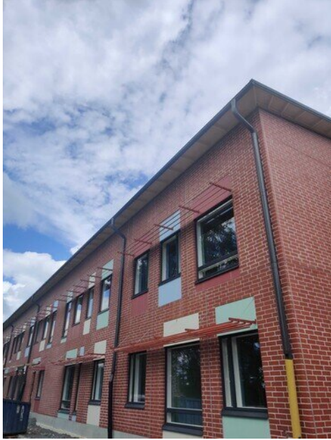
Aurinkosuojalipat asennettu
