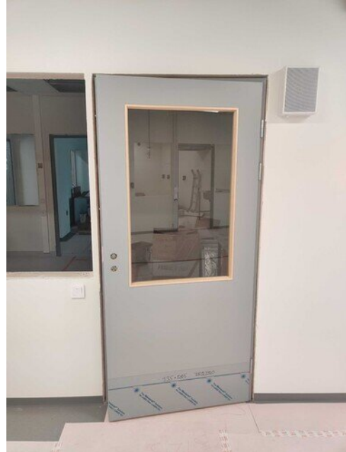
Sisäpuuvia asennettu paikalleen
