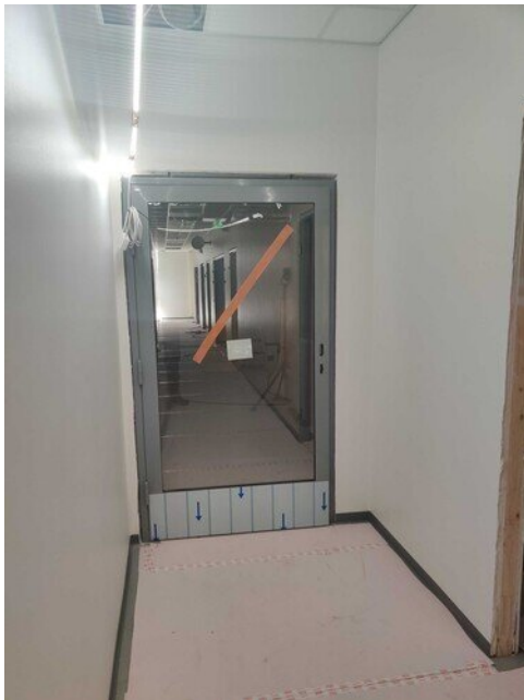
Sisämetalliovia asennettu
