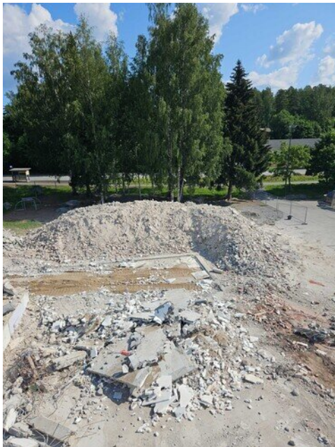
Tiili ja betonimurskaa
