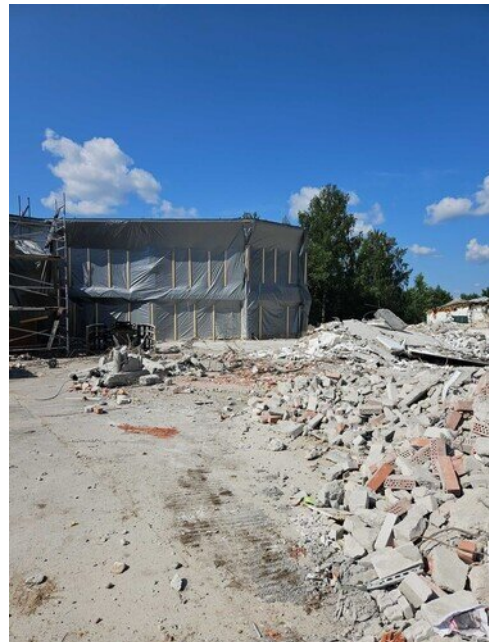
Väliaikainen sääsuoja asennettu
