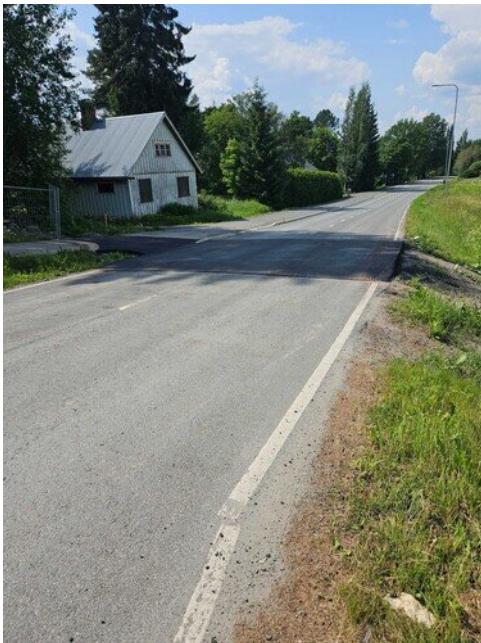
Hidastemöykky tehty asfaltilla väistötilojen sähkönsyöttöputkien päälle
