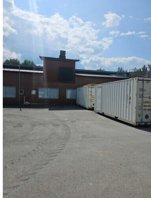
Koulun varastokontit, iv-raitisilma säleikkö ja ulospuhallushajottaja odottaa käyttöä
