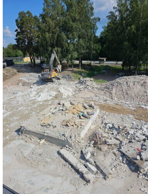
Lattian purku menossa
