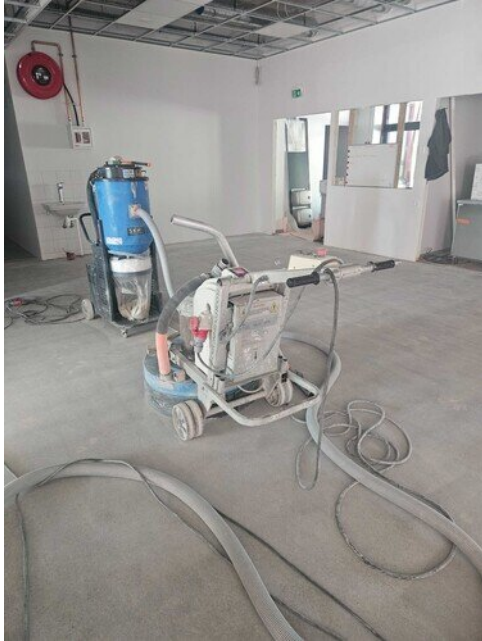
Eteisaulan kiiltobetonin hionta käynnissä
