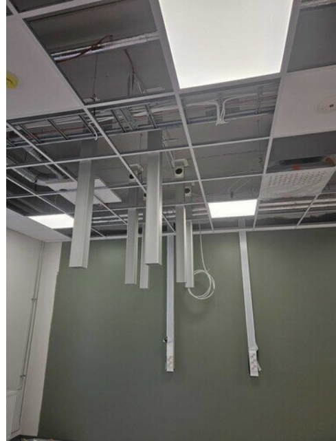
Imukärsien rungot asennettu kolvauspaikalle
