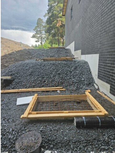
Pihaportaiden anturalaudoitukset odottaa betonia
