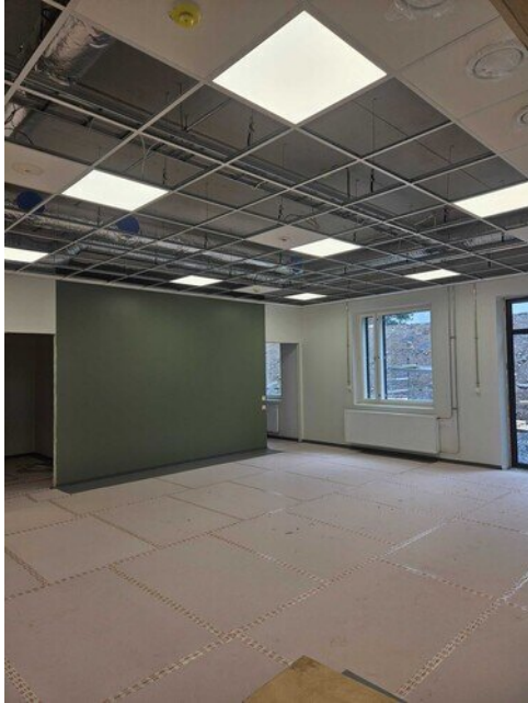
Valaisimet asennettu ja kytketty, tekninentyö
