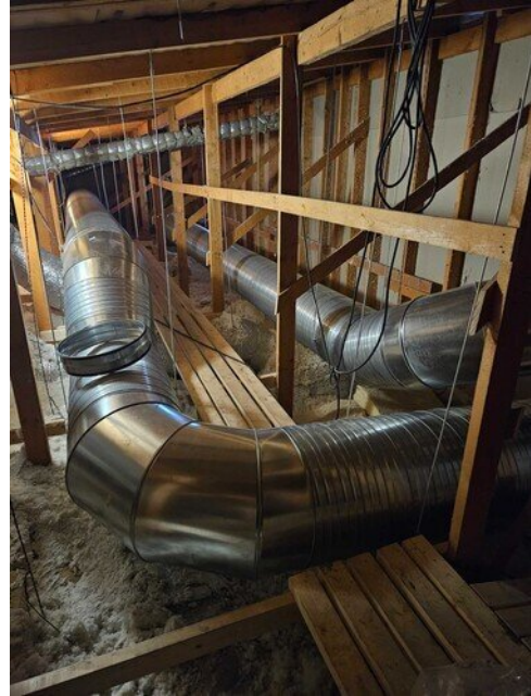
Kanavistoa asennettu kohti ruokalaa vanhalla ullakolla
