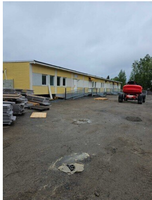
Sisäänkäyntien asennus käynnissä väistötila rakennus
