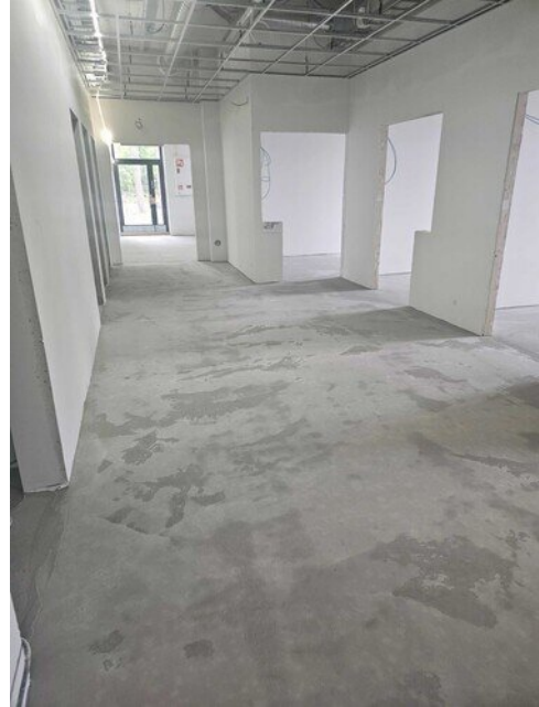
2. krs hallintosiipi lattia tasoitettu
