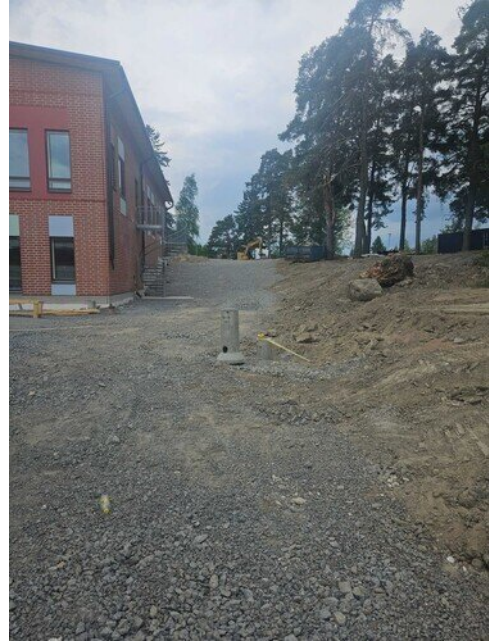
Valaisinpylväiden jalustoja asennettu ja asfalttipohjaa tehty
