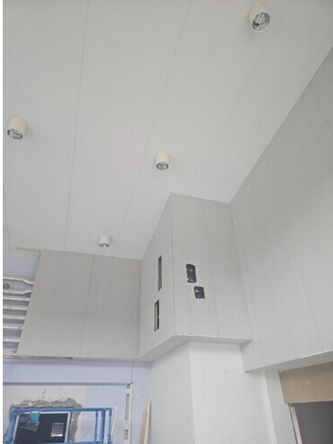
Vanhan aulan kotelointi aloitettu
