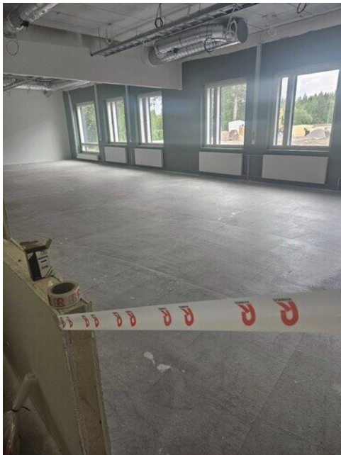
Luokkatilat odottaa maanantain tasoituksia
