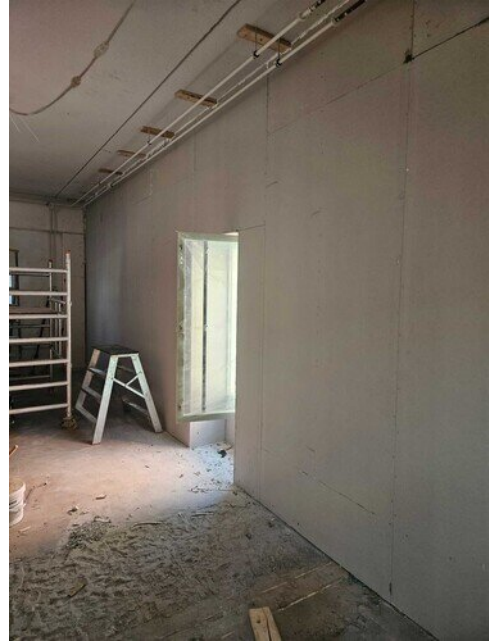
Ruokalan laajennuksen ulkoseinä koolattu ja levytetty
