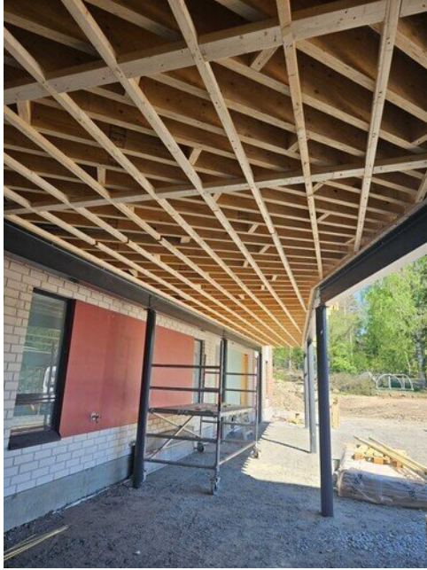
Sisäänkäyntikatoksen alapinta koolattu
