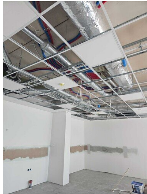
Alakattorungot asennettu alakertaan
