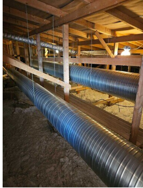
Ullakkokanava-asennukset aloitettu uuden IV-konehuoneen vieressä
