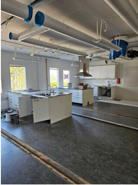
Kotitalousluokassa viimeistelyt käynnissä.
